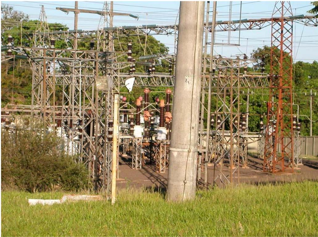
圖 5.22 138kV 斷路器與比流器個別設置
