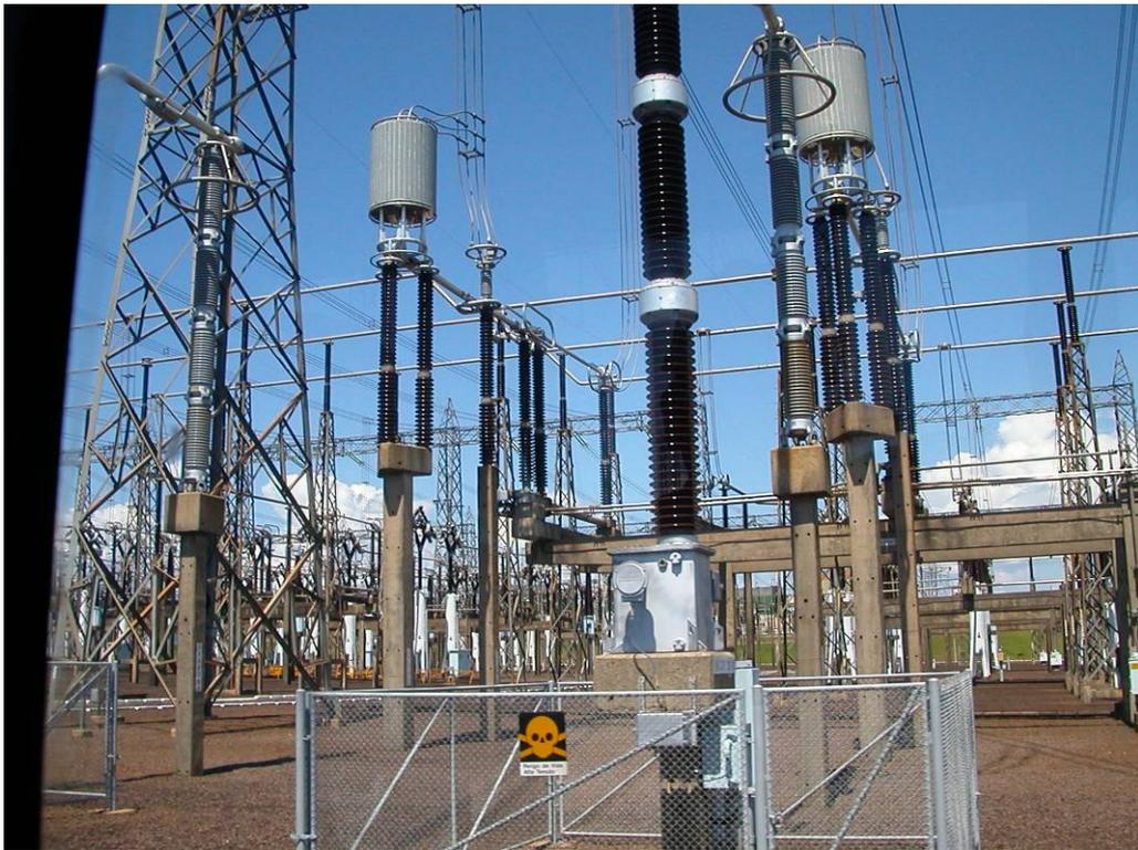
圖 5.7 500kV AC ABS、避雷器(LA)、線路比壓器(LPD)及 BUS 鋁管
