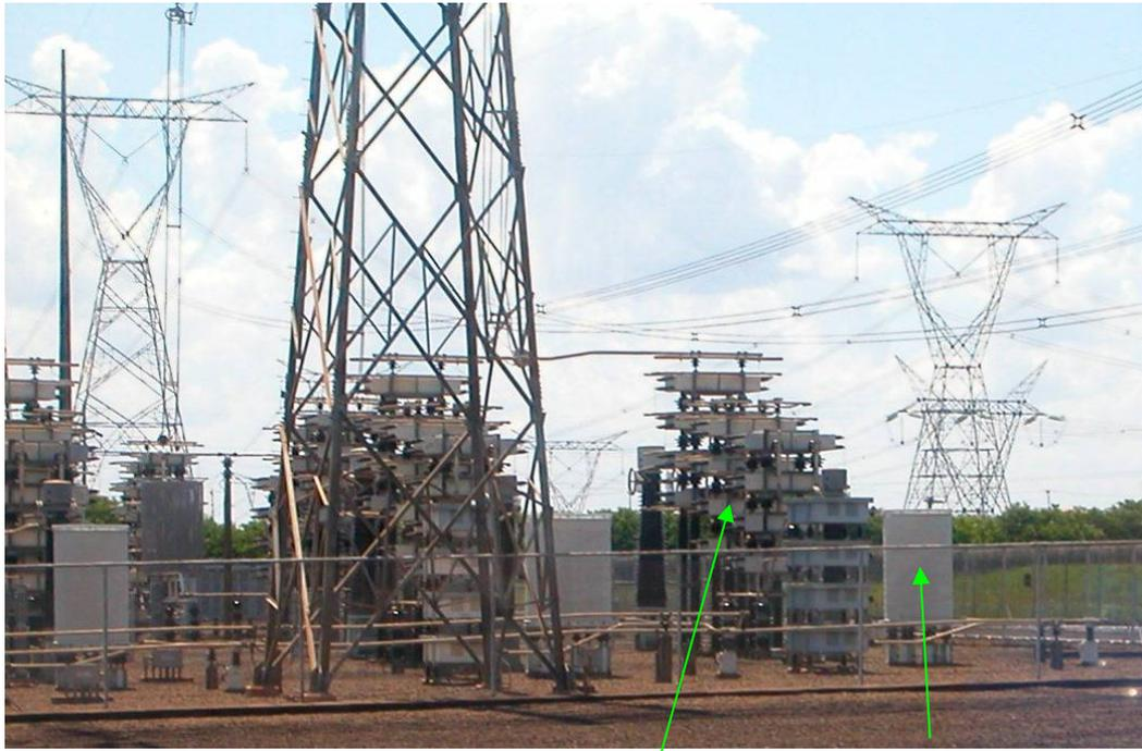
圖 5.9 諧波濾波器安裝在戶外，電容器為橫置方式，電感為空氣芯電抗器
