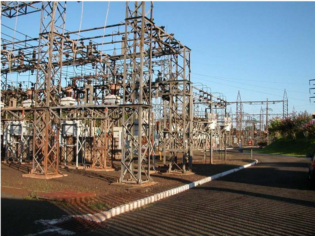
圖 5.21 伊瓜蘇配電變電所鐵構略有生鏽情形
