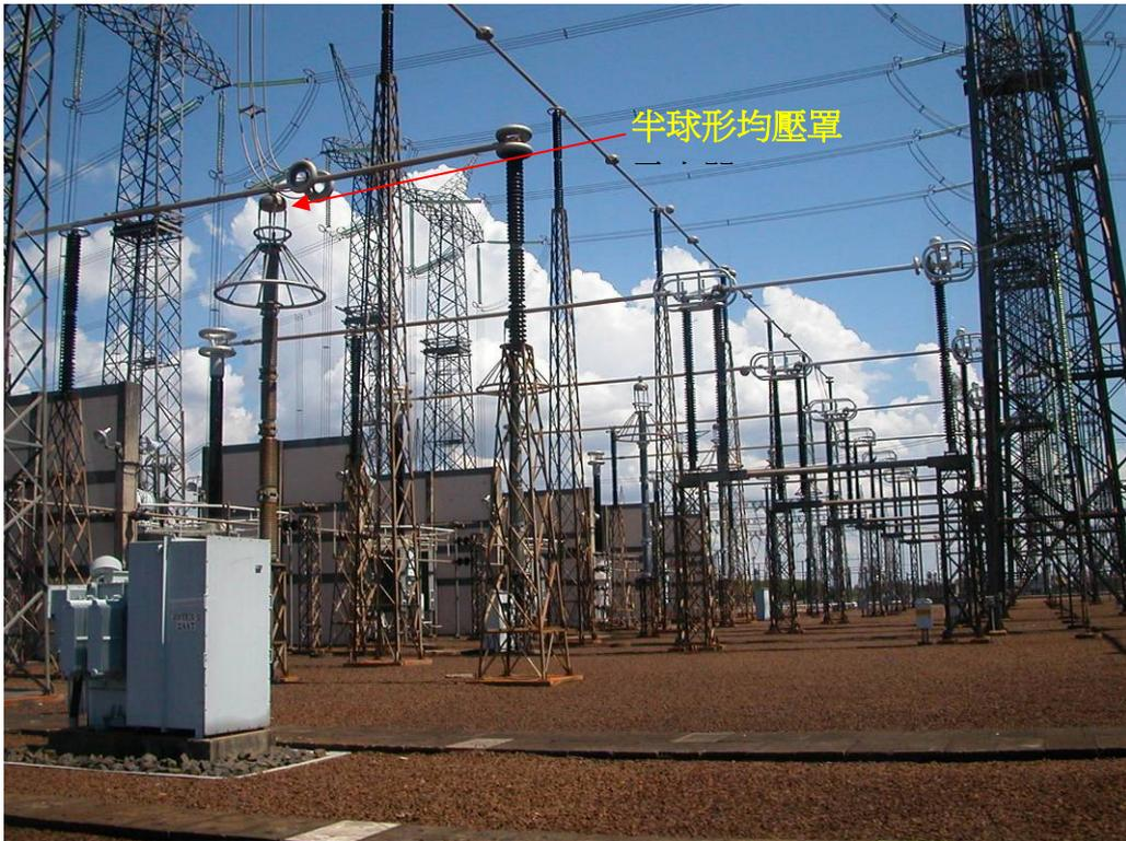
圖 5.15 換流站之 600kV 避雷器上設置了一個半球形均壓罩
