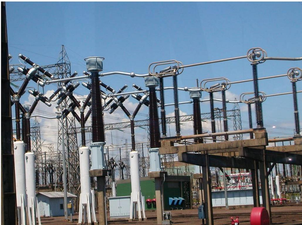
圖 5.8 500kV 斷路器使用空氣斷路器(ABB)
