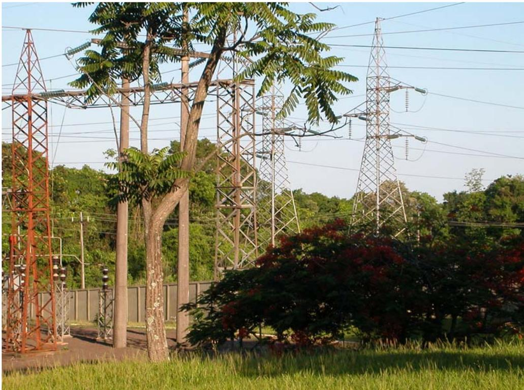
圖 5.23 138kV 架空線路引進變電所
