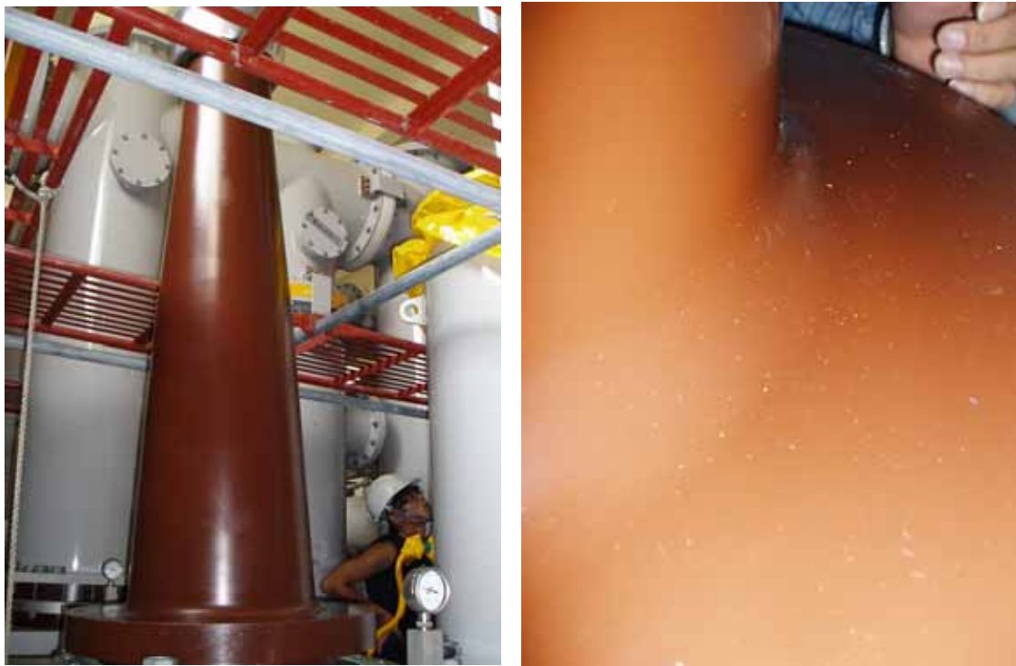
圖 5.1 絕緣套筒檢修
