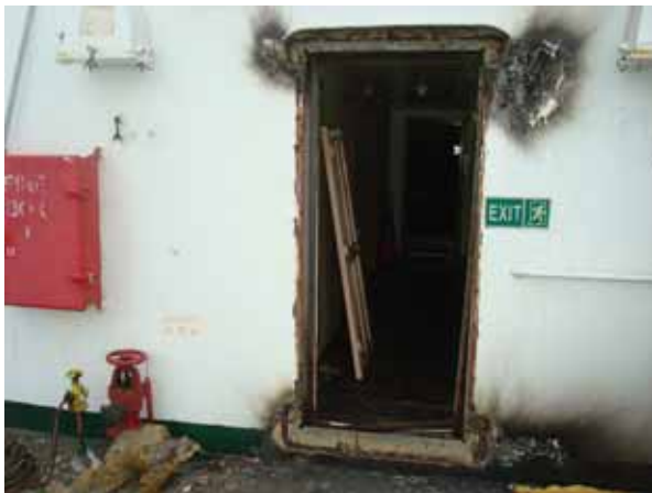
駕駛台門框修理
