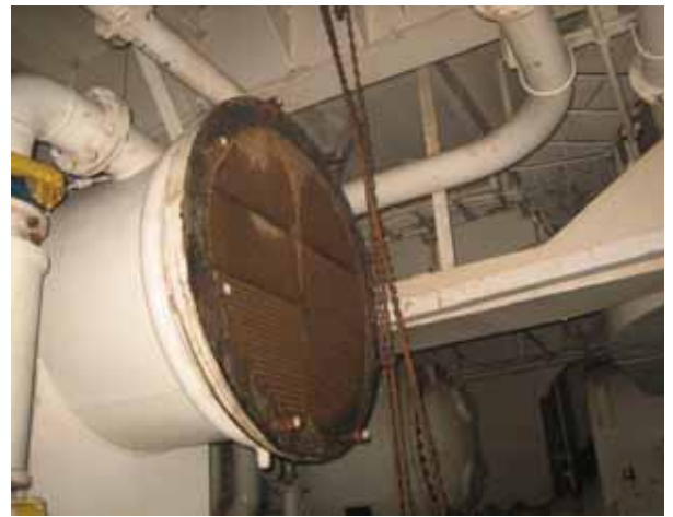
#2 主滑油冷卻器清洗
