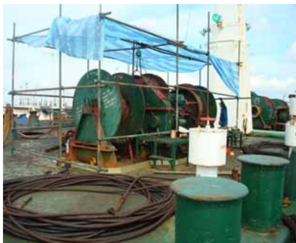
WINDLASS 安裝完成
