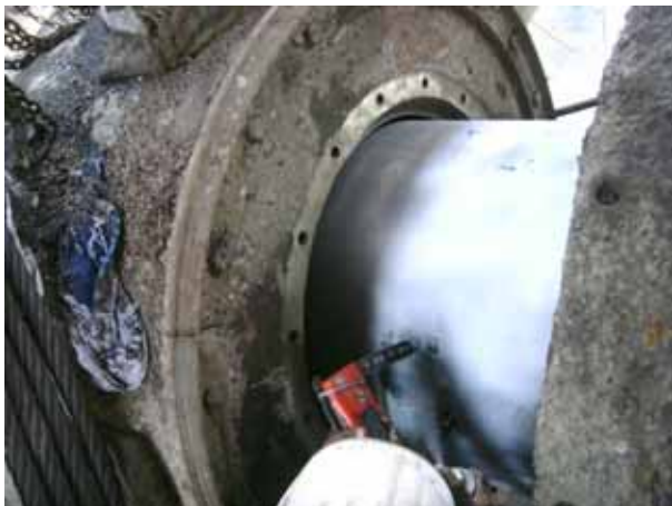
TAILSHAFT MPI 檢測
