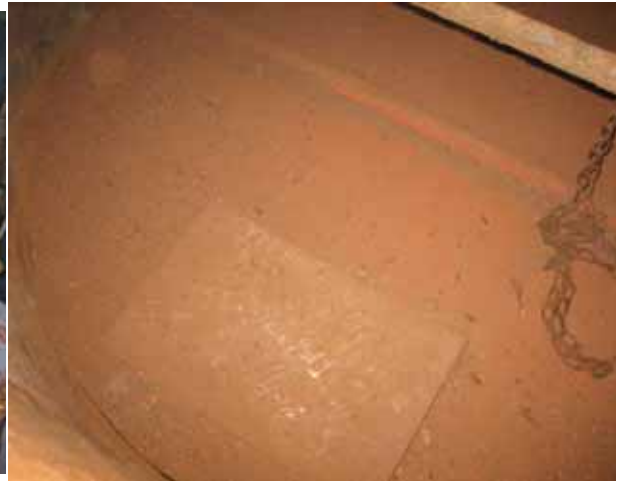
廠修通風檔板完工
