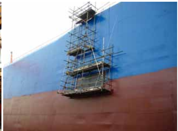
NO.2S SHELL PLATE 換板及搭架
