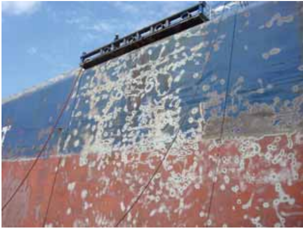
外板噴砂左舷 MANIFOLD
