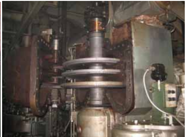
貨油泵 TURBINE ROTOR 安裝
