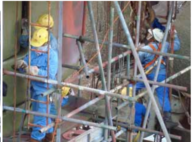
搭架 FOR 舵軸檢查及車葉艙軸拆裝
