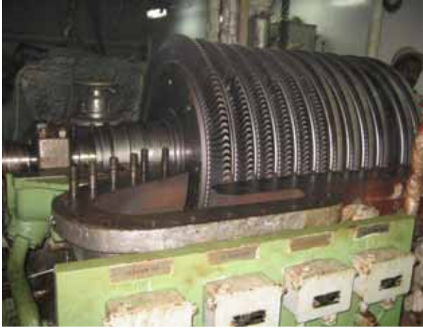
透平發電機 ROTOR 安裝
