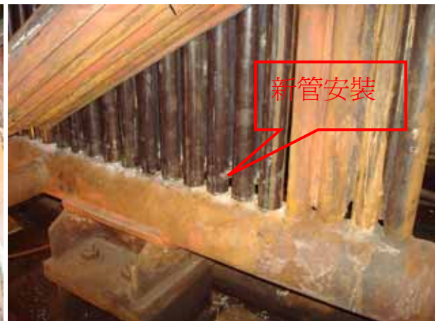
鍋爐爐管開始安裝
