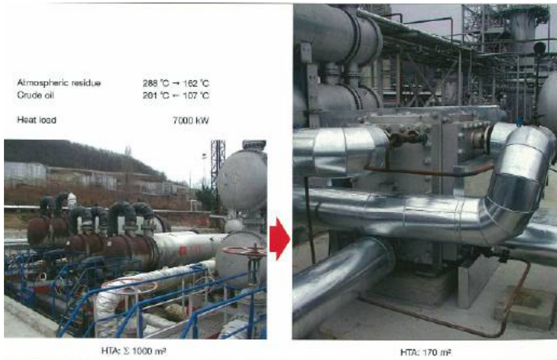
圖九：右圖中之板式換熱器可取代左圖傳統換熱器
