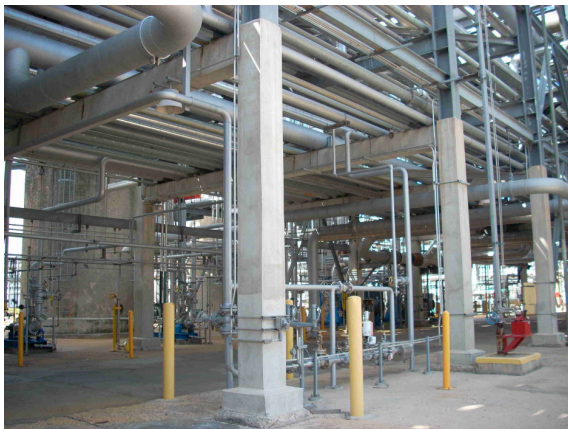
工場區內有被撞擊之虞的重要設備，其周圍均設置防撞措施或設施
