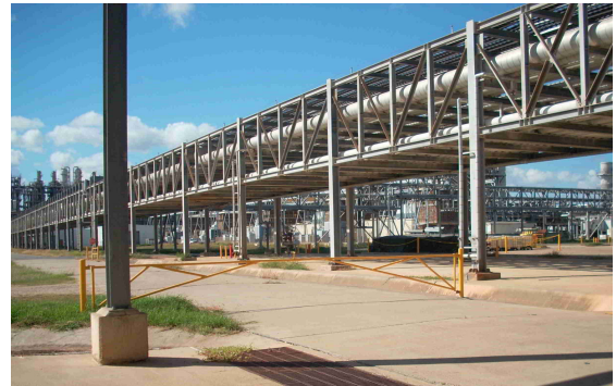
烯烴二廠工場區各出入口設置活動式閘門
