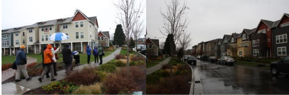
這個計畫係整合既有的大型和高密度住宅區都市自然排水系統（Natural Drainage System, NDS）觀念，結合新的社區成為街網時也創造一個網絡連接植栽和綠地的線狀沼澤帶。這樣的方式可以達到社區綠地空間、行人安全和水質改善需要的平衡。
