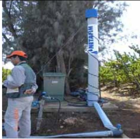
圖 20 採用自然重力加壓式，即利用坡地落差或水塔上下落差之滴灌設備
