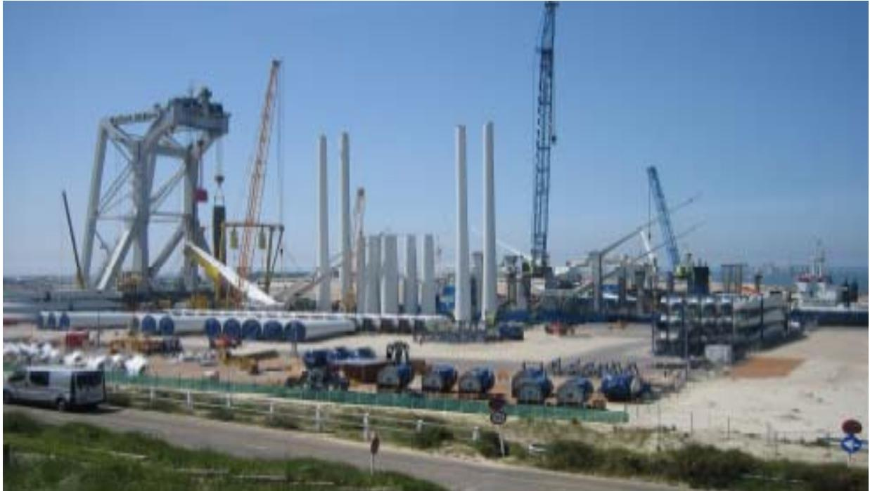
圖 20 離岸風力發電機預裝組情形
