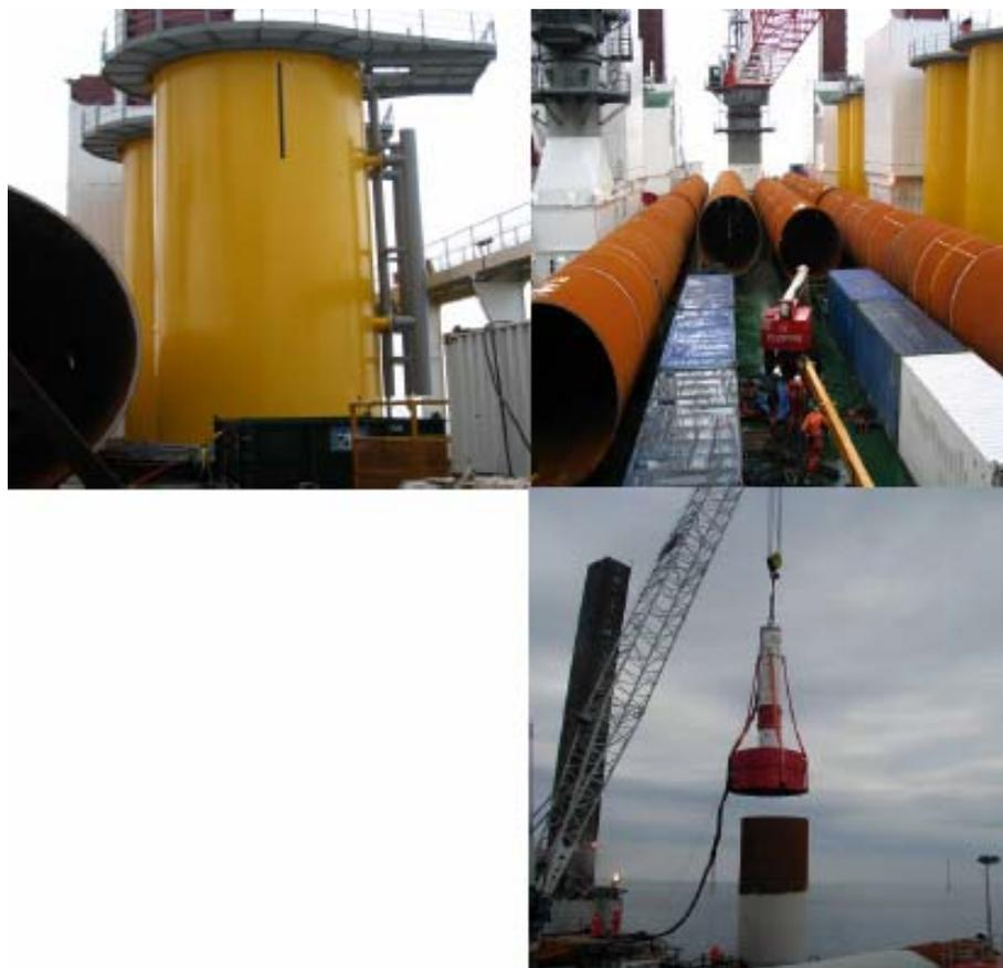
圖 17 離岸風力發電機塔架安裝過程
