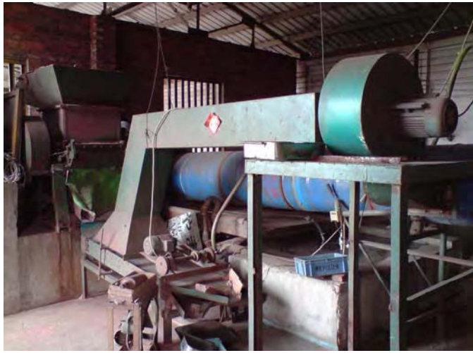
照片 37 佛山市中陽處理廠處理設備
