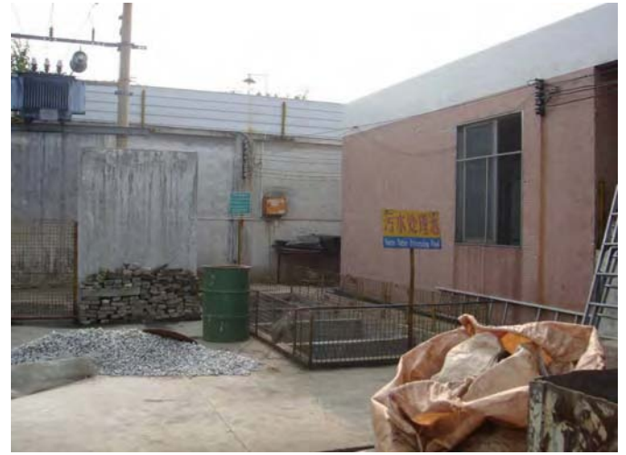
照片 32 佛山市中陽處理廠設有污水處理池
