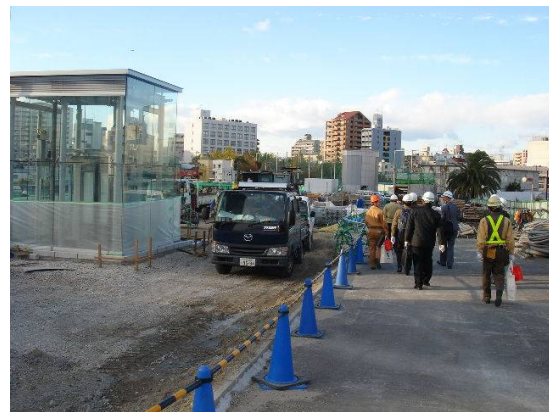
巨蛋前車站地面工地情形
