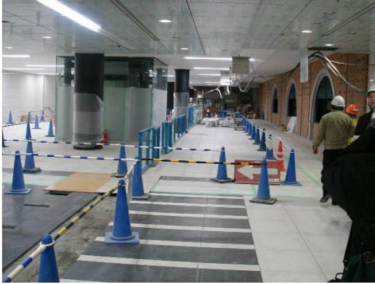
大阪運動場前車站內工地情形
