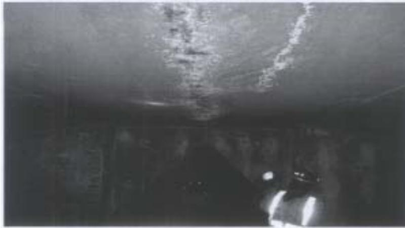
圖 2.23 箱型梁內中性化、裂縫和碎裂區域
