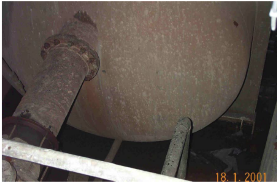
圖 2.2.1-11：案例 11 Blowdown vessel showing water level
