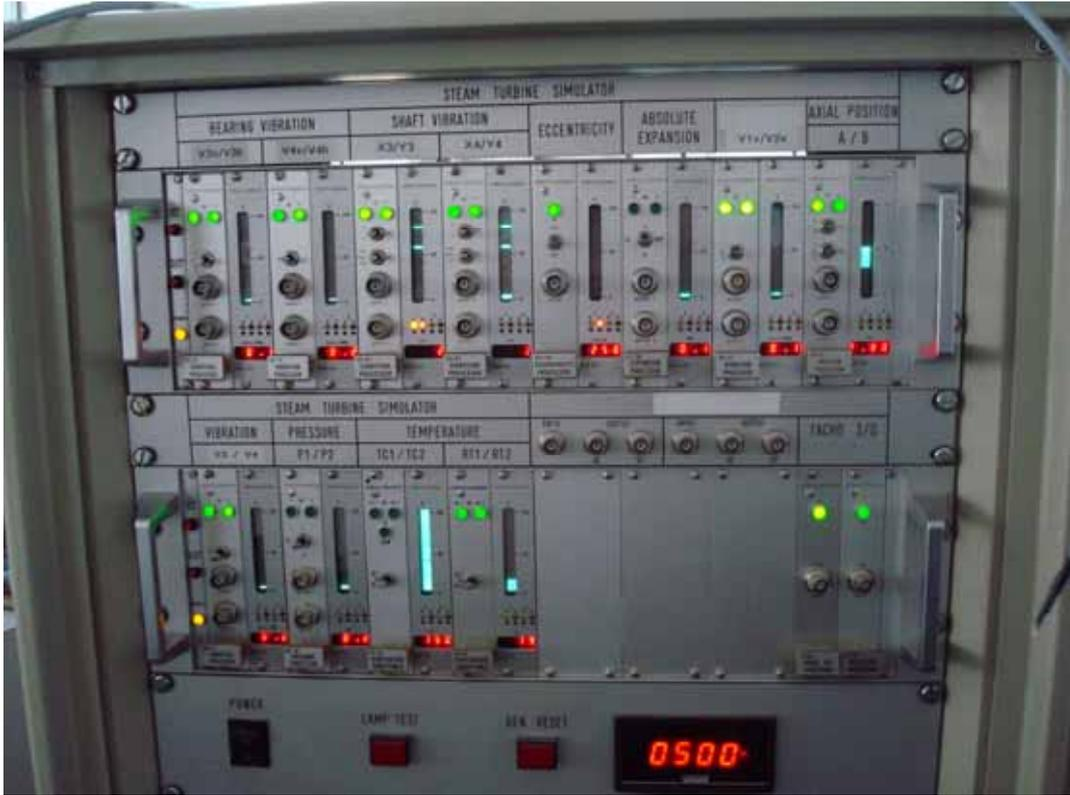
圖 23、目前台灣 Siemens 機組所使用 Vibro-Meter 的振動監測系統
