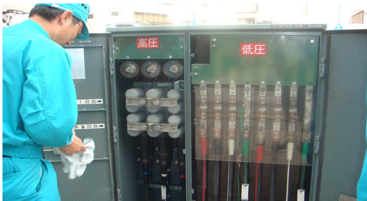
側開式變壓器箱體（左為高壓側、右為低壓側）
