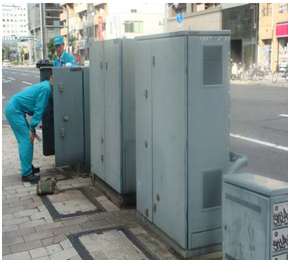
中電公司路上變壓器(右二 50+100KVA)及開關(左二) 中電公司路上設備外型較高較薄
