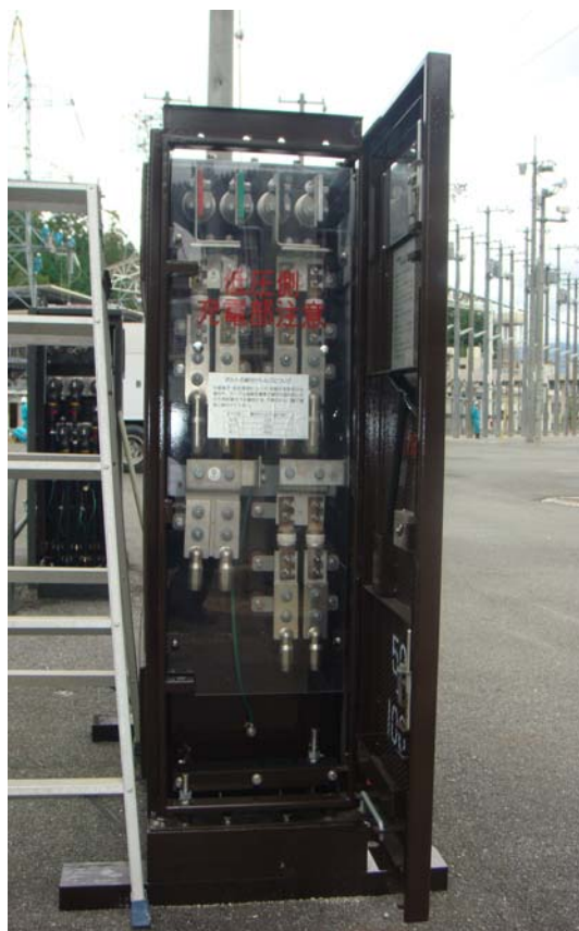
側開式變壓器箱體（左為高壓側、右為低壓側）
