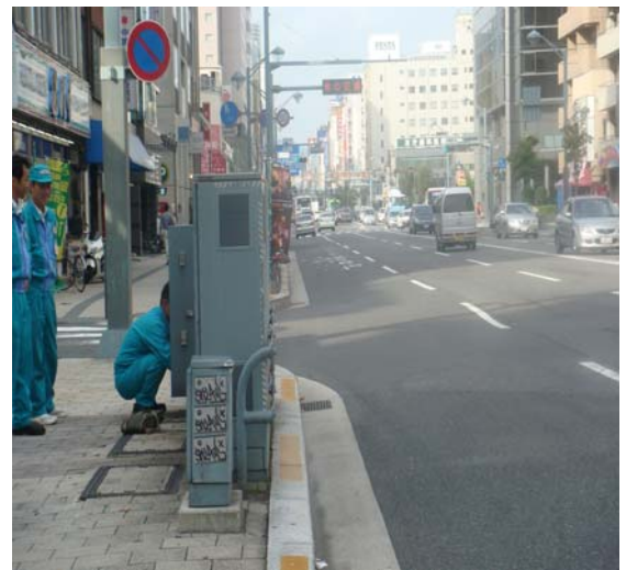
中電公司路上變壓器(右二 50+100KVA)及開關(左二) 中電公司路上設備外型較高較薄
