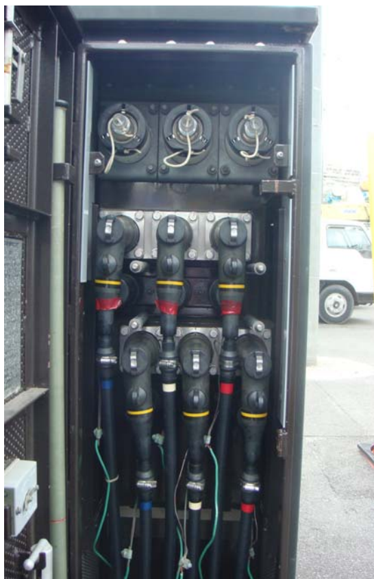
側開式變壓器箱體（左為高壓側、右為低壓側）
