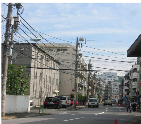
日本住宅區內巷道桿線均未地下化
