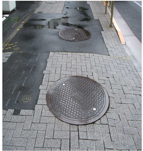
施工後設置於地磚道上人孔亦十分平整
