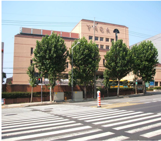
高壓供電用戶
