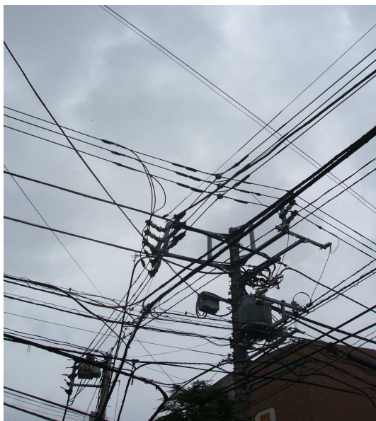
日本架空配電線路空中 接線裝置情形
