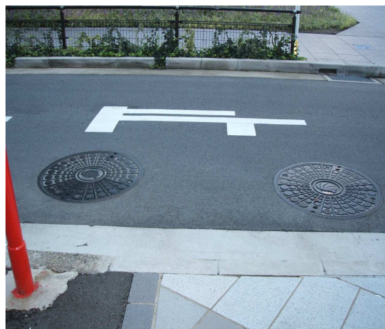
道路上人孔蓋十分平整
