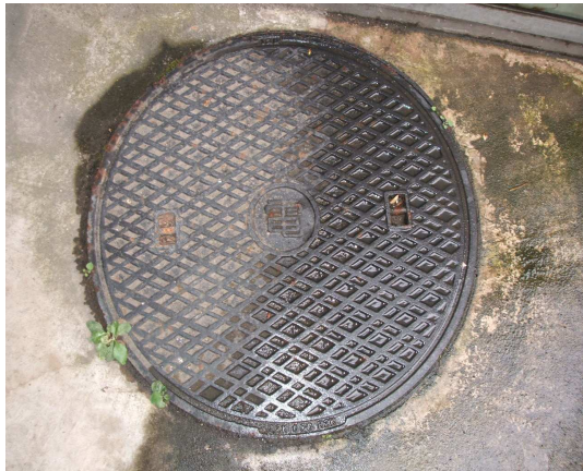
手孔埋設埋設情形
