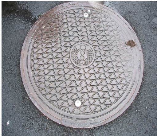
設置於道路上人孔十分平整
