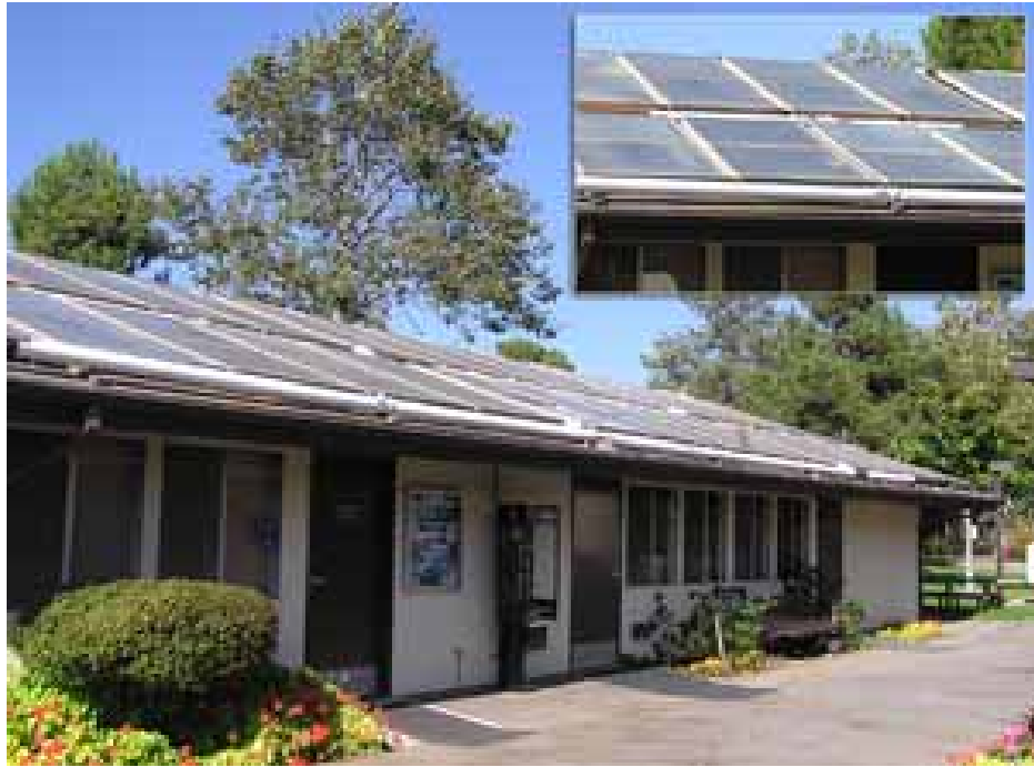
圖十一 屋頂太陽能發電系統裝設實例照片
