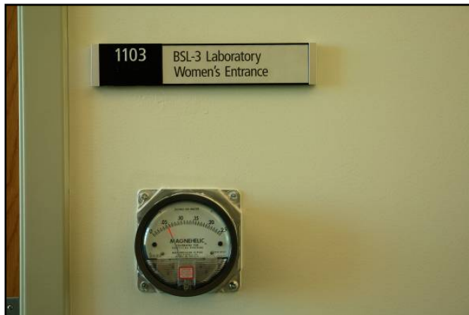
圖 15、Building 21 實驗室內有多間生物安全第三等級 BSL-3 實驗室。
