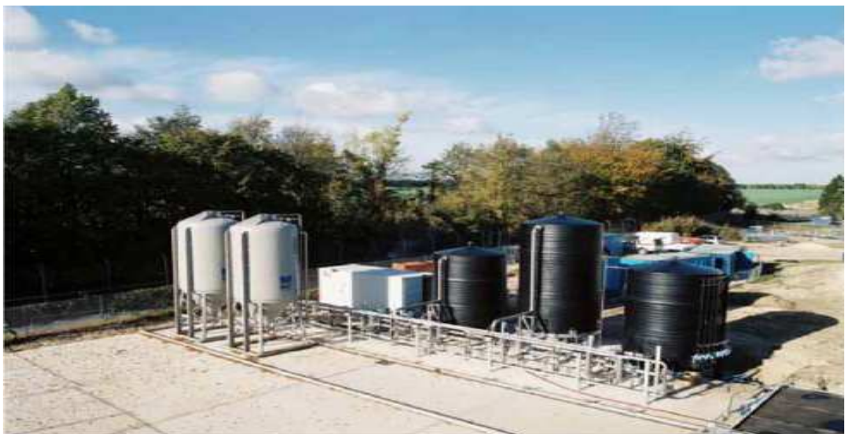
圖 12. WSA 設置地下水抽出處理廠外觀
