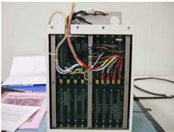
圖五、安裝 UPD 最終電源接頭螺
