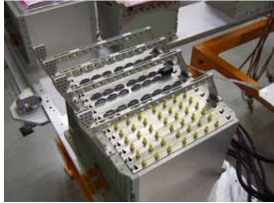
圖十六、U0 纜線支撐架安裝
