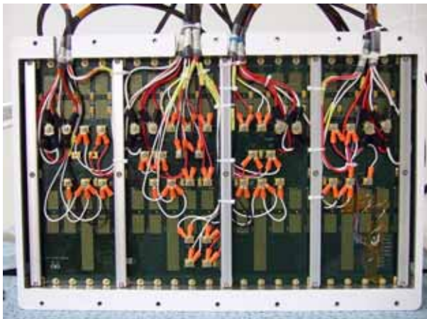
圖九、JT 最終電源接頭螺絲安裝
