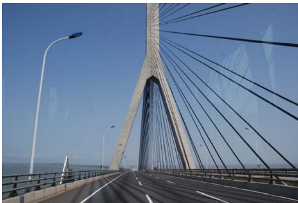
圖三、東海大橋一景
