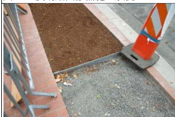
圖 45：人行道鋪面施作情況
