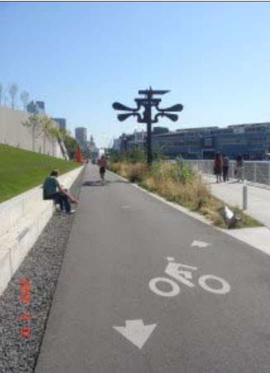
圖 22：自行車道旁之碎石淺溝
