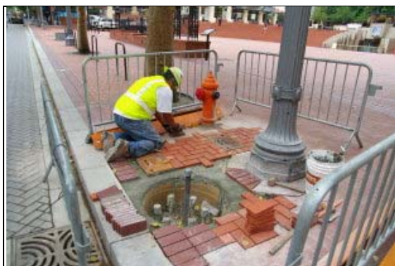
圖 43：廣場鋪面修補施工狀況
