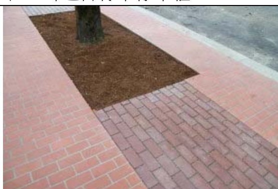
圖 46：施工品質精良之完成面
