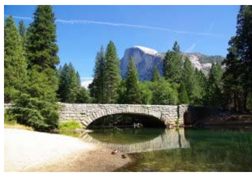
圖 69：公園內車道跨橋
