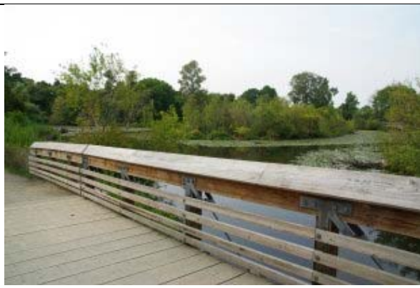
圖 39：濕地集成木跨橋
