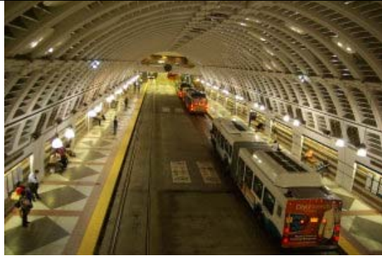
圖 9：西雅圖公車隧道
