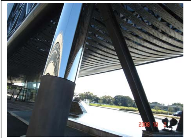
底部這4根支柱支撐315 m的太陽方舟，底部寬度：13.7m，離地20 m高
