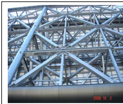
底部這4根支柱支撐315 m的太陽方舟，底部寬度：13.7m，離地20 m高
