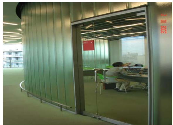
玻璃磚牆作為內外隔間牆。
