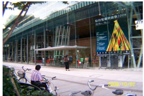
館外亦能看到館內骨架結構
