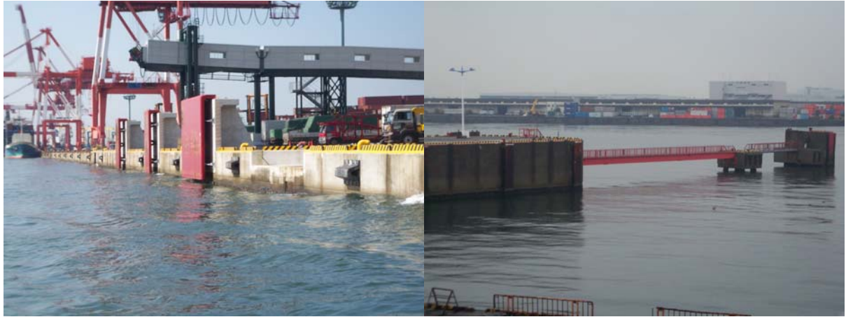
圖 19：客輪碼頭護舷及離岸式繫靠設施
