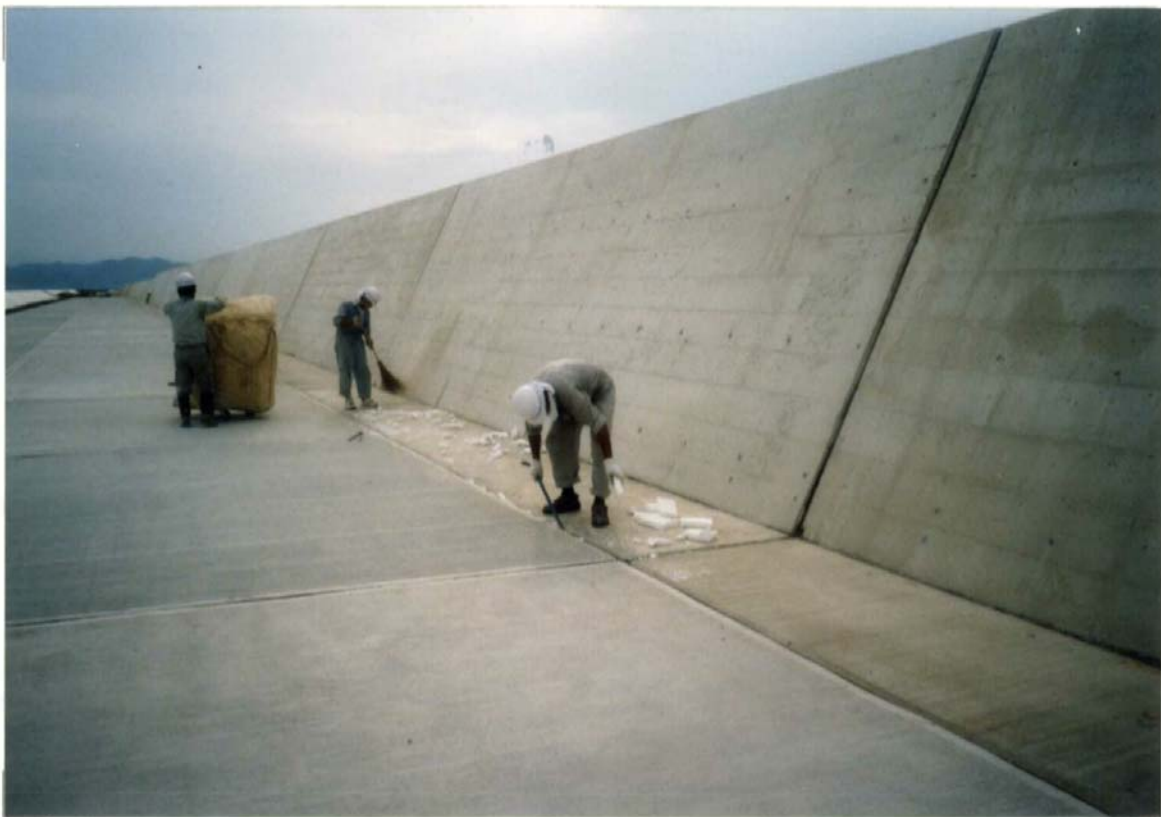
圖 2：設置透氣層施工照片
