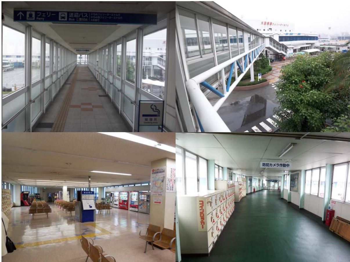
圖 17：大阪港南港舊渡輪碼頭旅客中心及空中走廊
