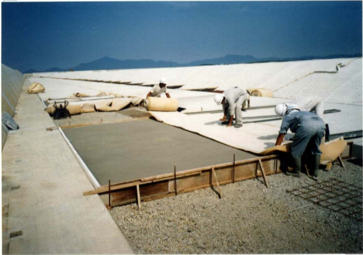
圖 1：設置透氣層施工照片
