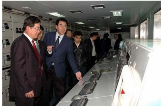
育鯤輪之機艙控制室
