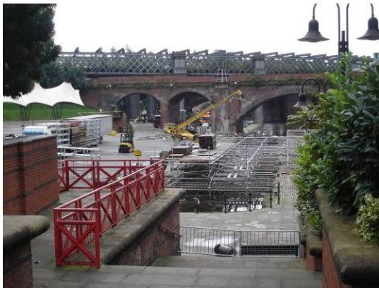
【照片 49】都市遺產公園(Castlefield Urban Heritage Park) 保存修護實況。(註 1)
