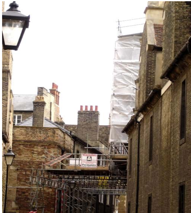
【照片 09】劍橋大學城中學院修復實況（註 1）
