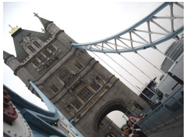
【照片 115】倫敦塔橋（Tower Bridge）上仰示方型五層主塔一景。（註 1）
