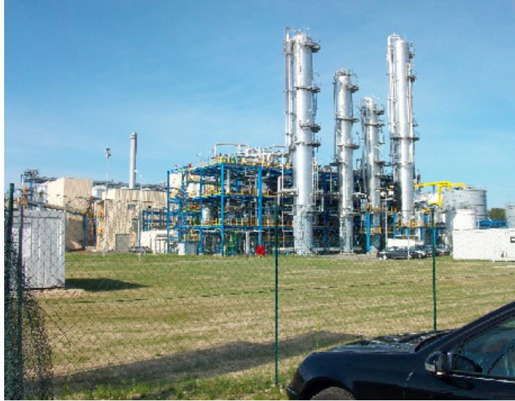
圖九、Agrana 生質酒精工廠外觀，其中四支蒸餾塔為酒精萃取單元。
