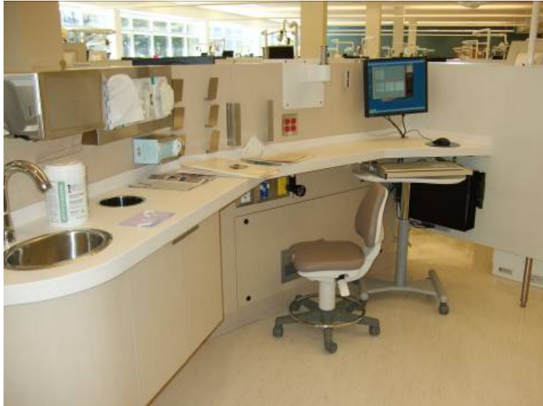
UBC 牙醫系學生門診，治療台旁的工作桌配置電腦設備，桌面下方氣體出口可供應麻醉用的笑氣(一氧化氮，NO)。
