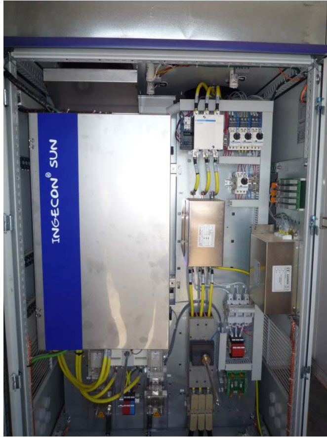
圖 2-12 電力調節器內部構造
