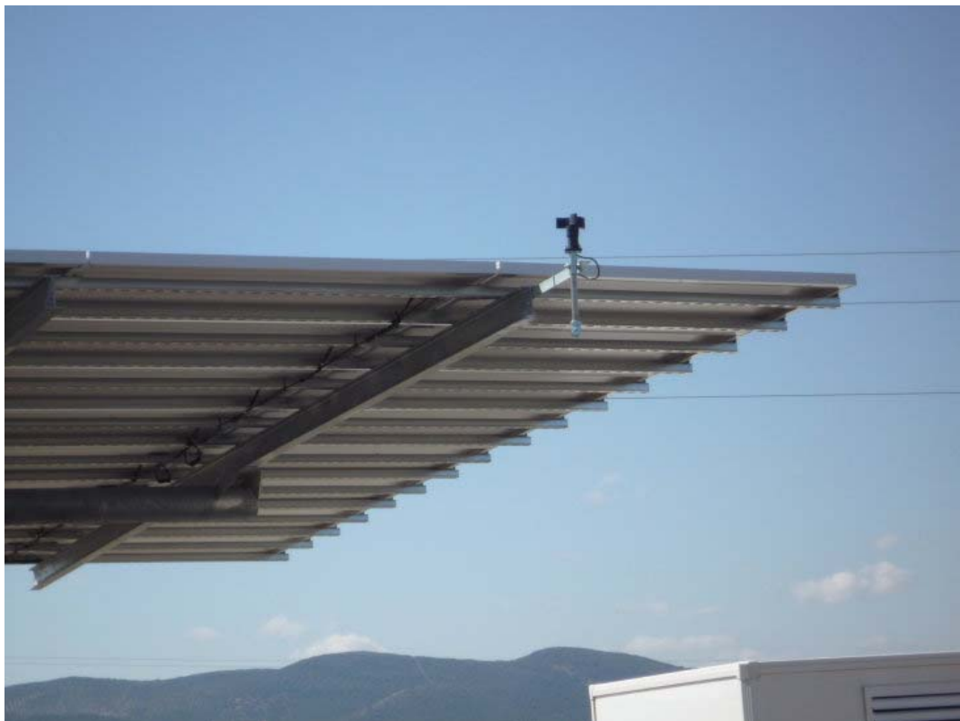
圖 2-25 每支 Tracker 上均設有風速計
