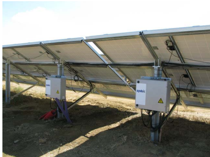
圖 2-36 電子式直流接線箱設置外觀
