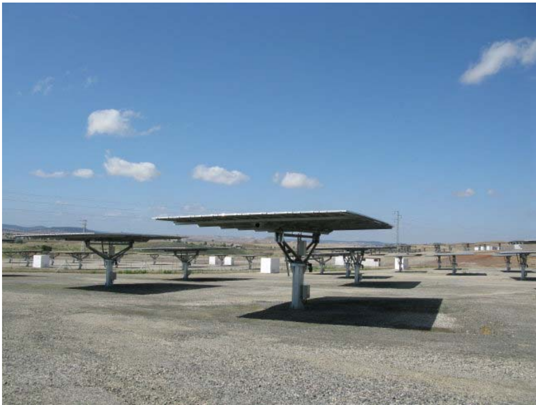
圖 2-3 3.09MWp 矽晶追日式系統(3)
