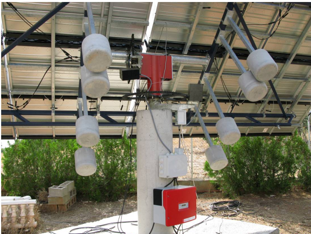
圖 5-2 3kW 聚光型系統須加以減少馬達驅動俯仰齒輪的功率
