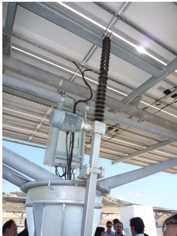
圖 2-7 追日機構轉動裝置(驅動傾斜角)
