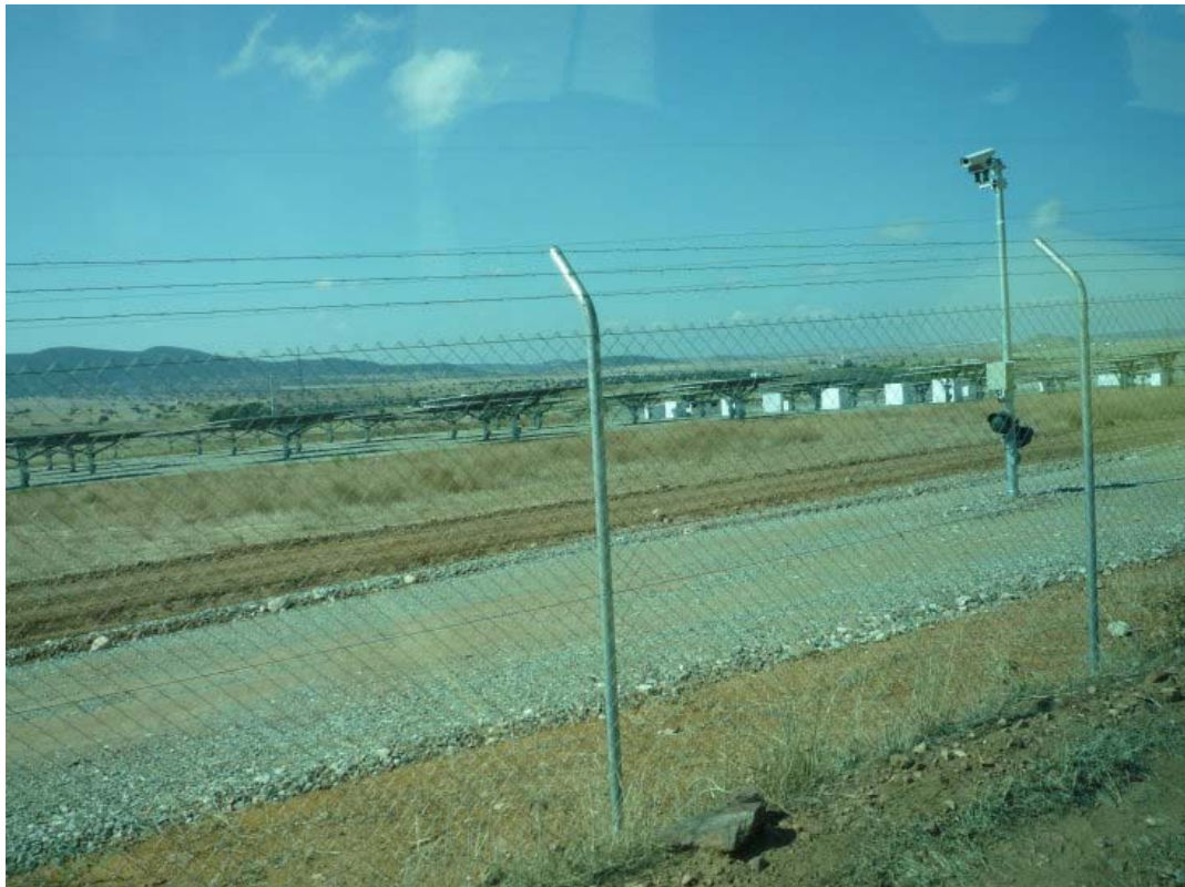
圖 2-27 整個廠區外圍設置鐵絲網圍籬，並設置監視器
