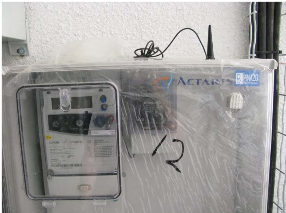
圖 2-19 6 組電力並聯，透過一組無線傳輸系統傳送發電資料
