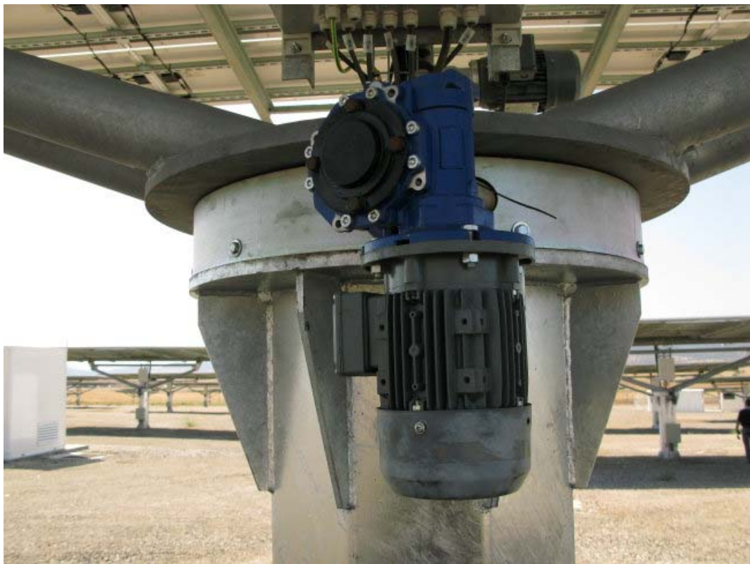
圖 2-9 追日機構驅動馬達(驅動水平轉向)
