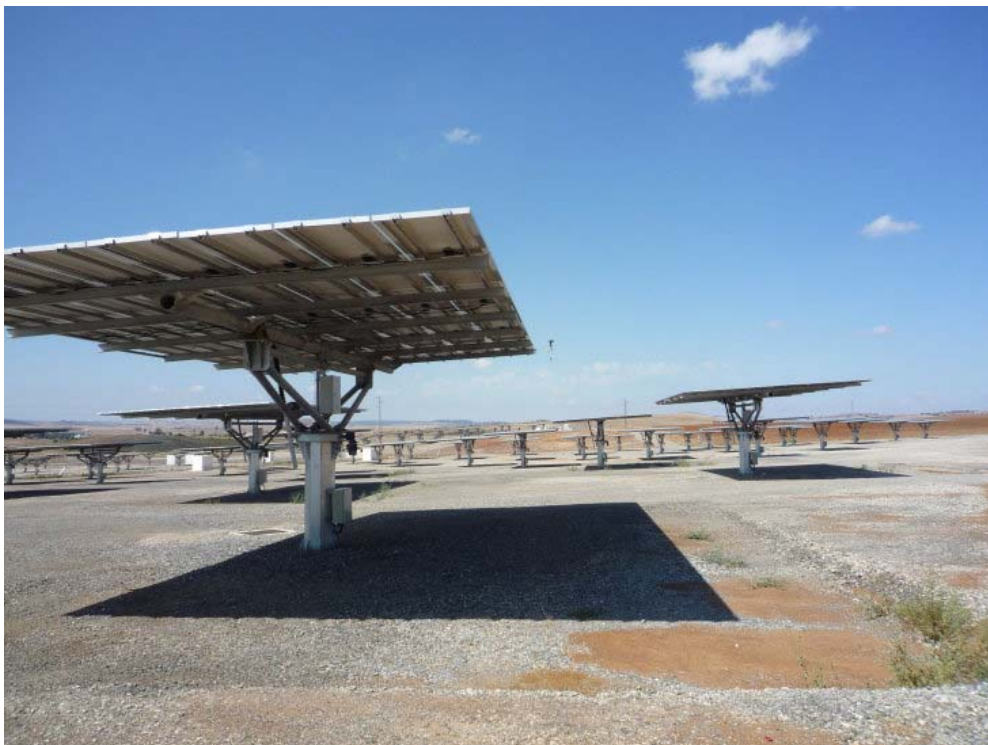
圖 2-1 3.09MWp 矽晶追日式系統(1)
