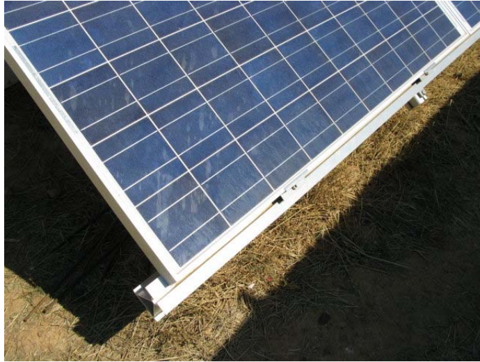
圖 2-41 模組安裝固定方式(2)
