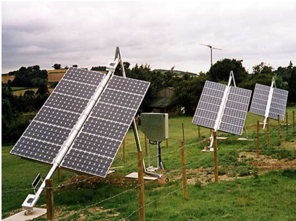
圖 1-25 Traxle 公司所開發的單軸追日太陽光電系統
