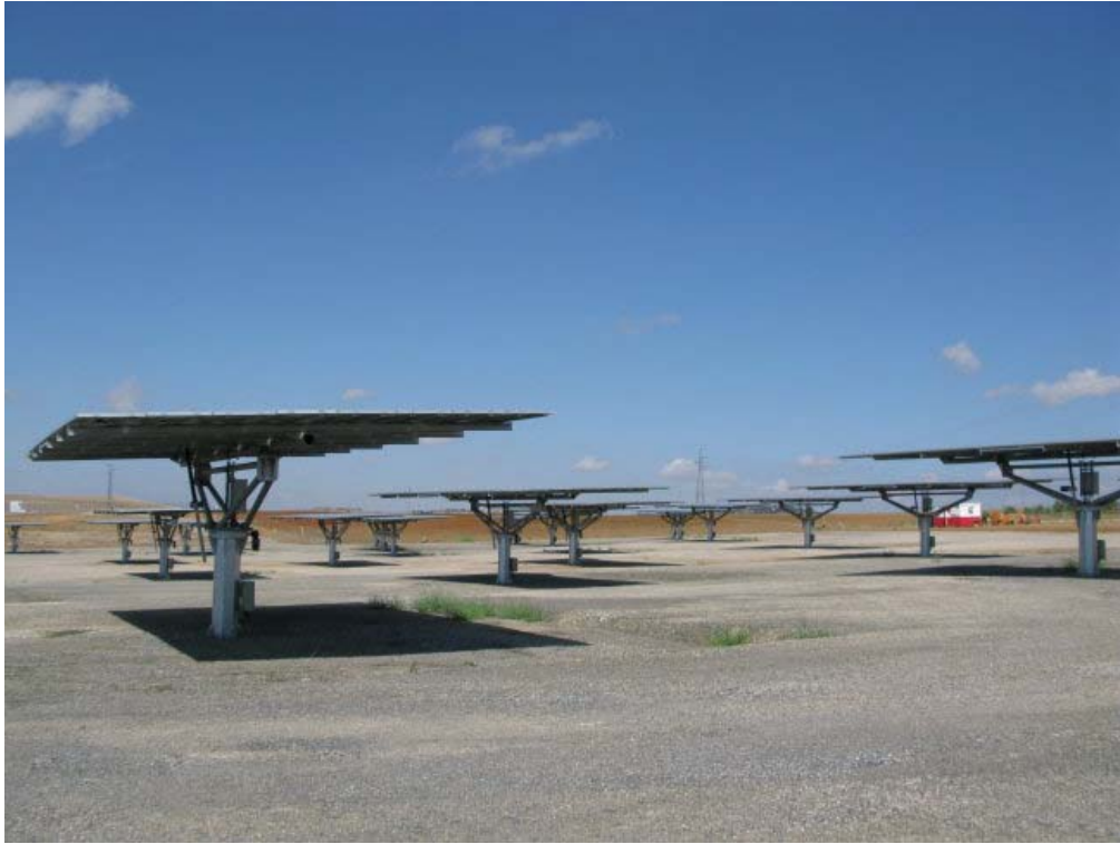
圖 2-2 3.09MWp 矽晶追日式系統(2)
