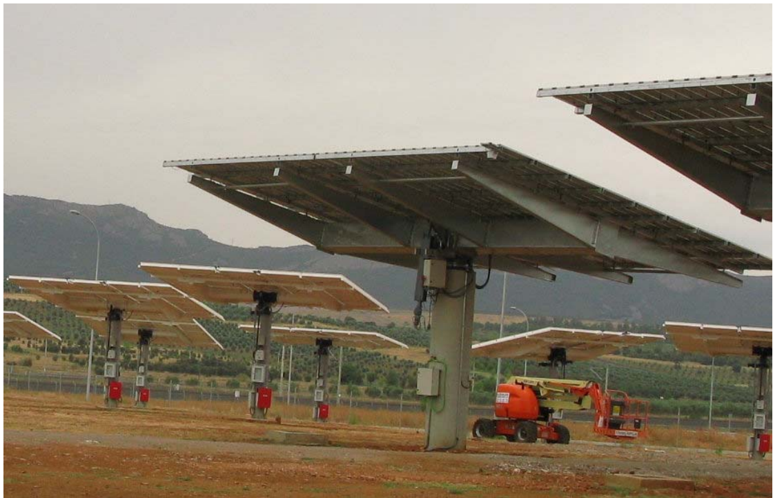
圖 3-9 二種不同型式聚光型系統(Isofoton 和 SolFocus)，其模組厚度並不大(聚焦和散熱技術有關)
