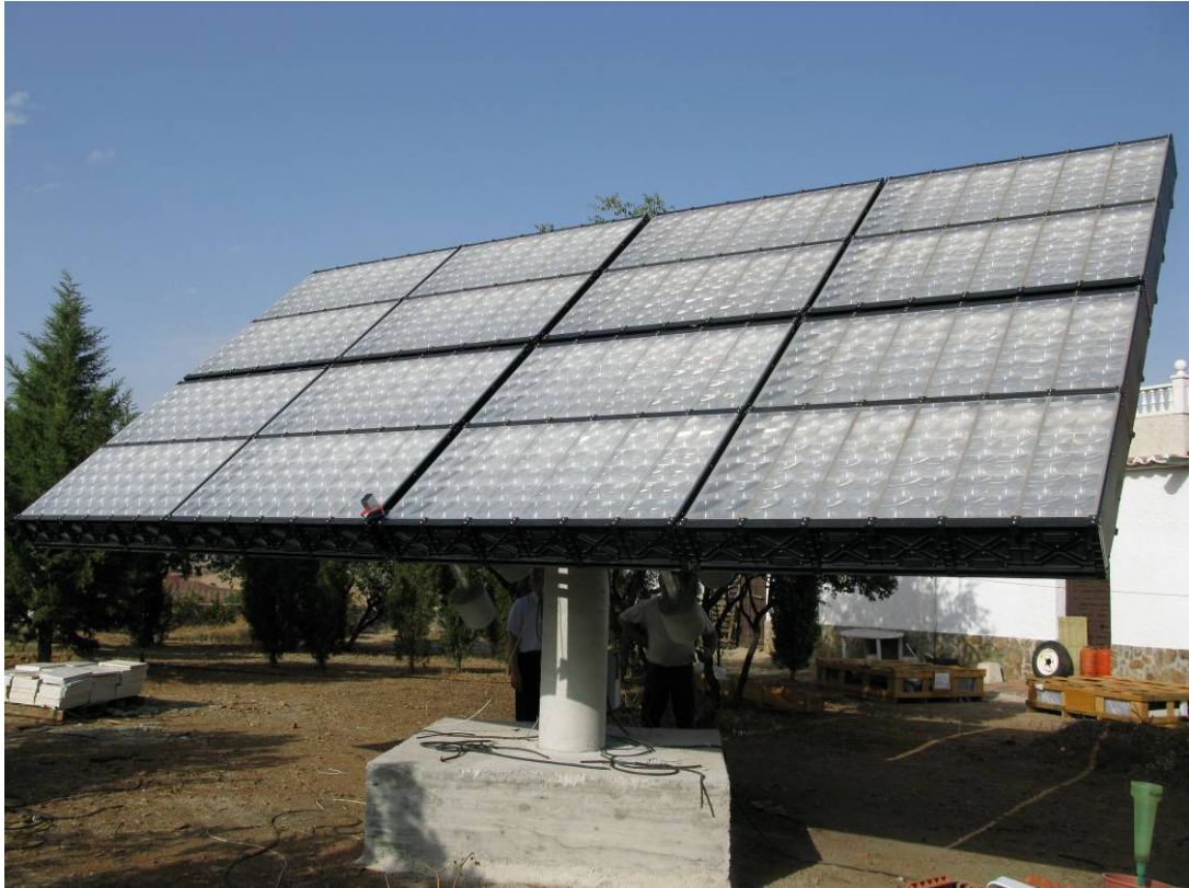
圖 5-1 Arima Eco 公司每支 3kW 聚光型系統
