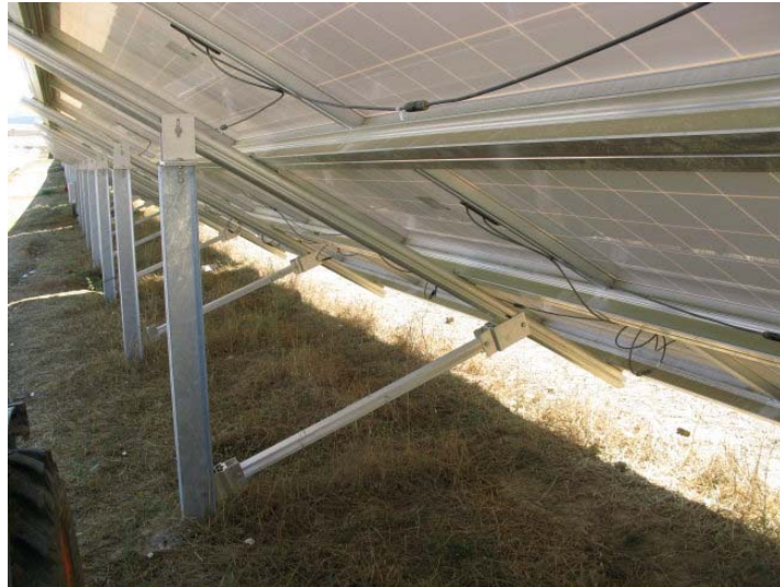
圖 2-39 懸臂式支撐系統以鋁擠型構材組立而成
