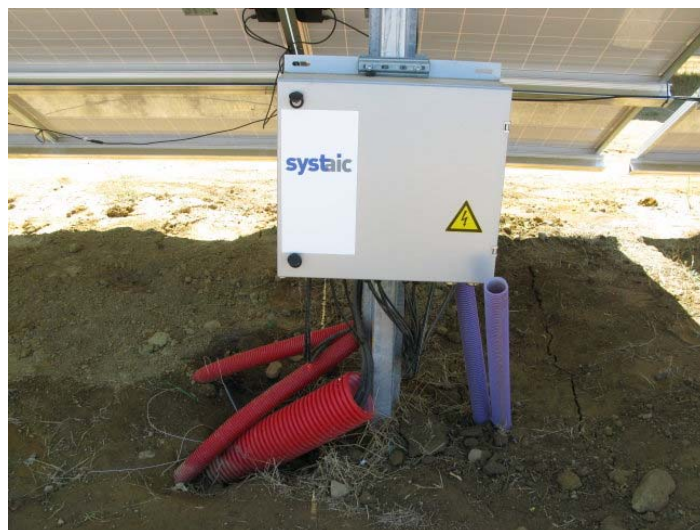
圖 2-45 直流接線箱外部配線凌亂，且未用金屬軟管包覆
