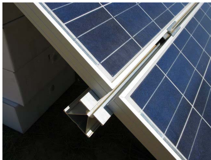
圖 2-40 模組安裝固定方式(1)
