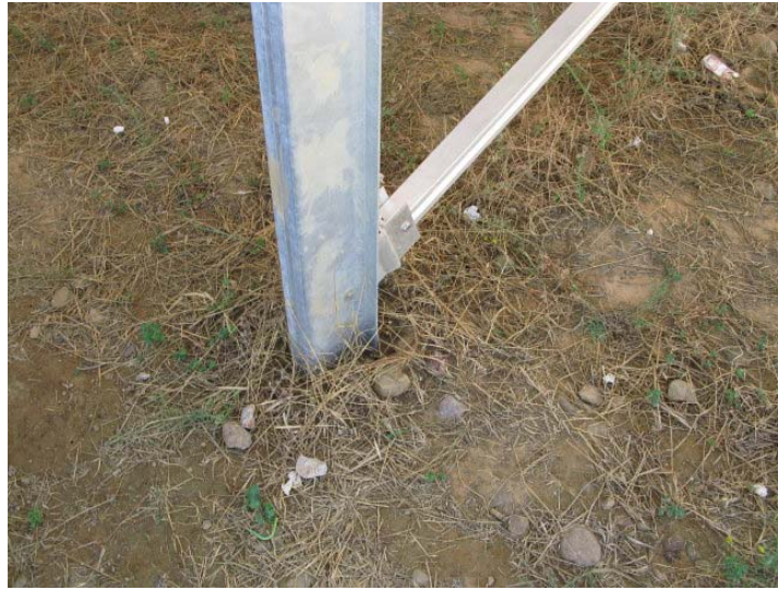
圖 2-38 將熱浸鍍鋅型鋼直接以機械方式植入土壤作為單柱式主支撐架
