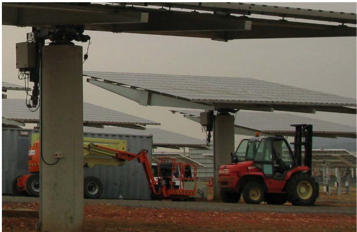
圖 3-11 施工及維護用的高空作業車及堆高機
