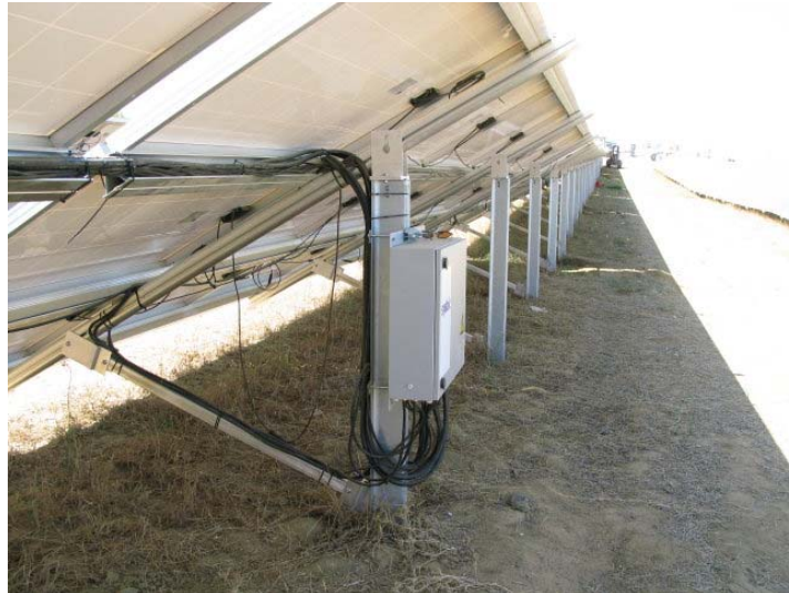
圖 2-45 直流接線箱外部配線凌亂，且未用金屬軟管包覆
