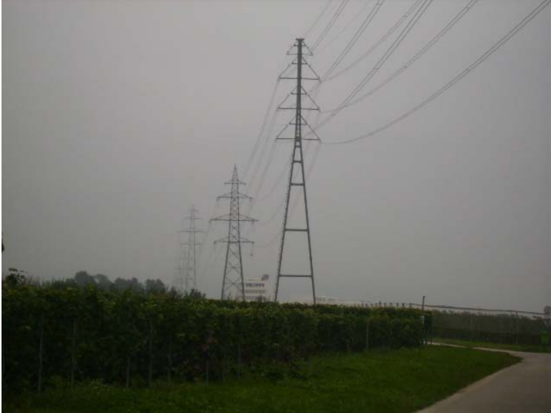
圖 4.5 懸擺式縮合型鐵塔
