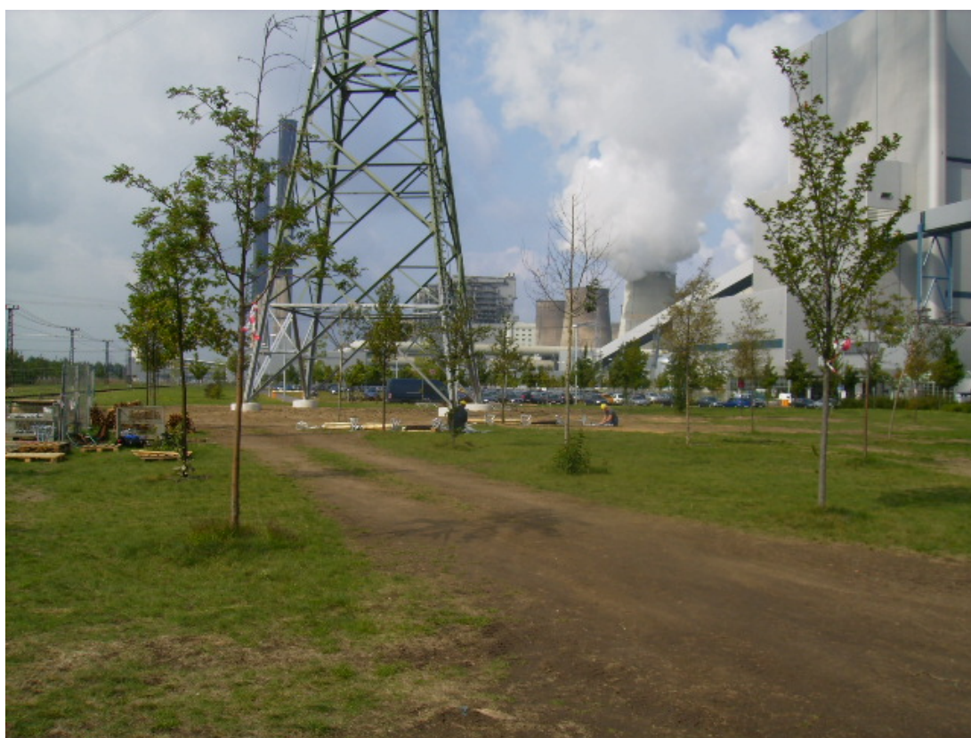
圖 2.4 配合電廠更新施工中之輸電線路
