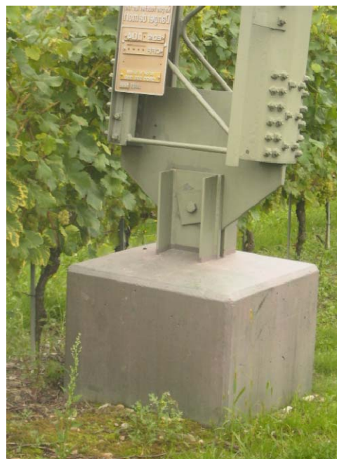
圖 4.9 懸擺式鐵塔的基礎
