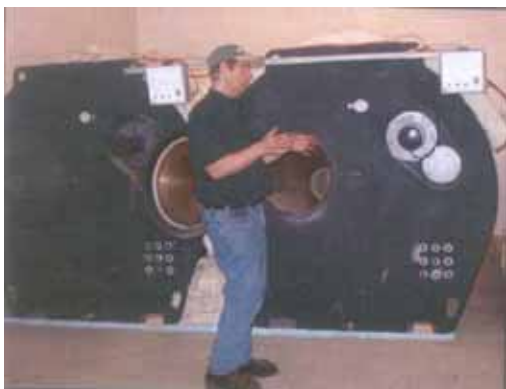
阿拉斯加熱能技術員大衛(Dave Frederick)說明位於坦那那的 GARN 木料鍋爐操作方法。(照片提供:Daniel Parrent)
