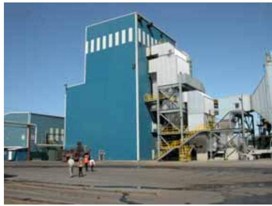
生質能源廠房
