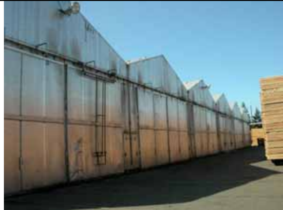
生質能源廠所製造能源大部分供應製材廠電力及部分轉為蒸汽提供乾燥廠乾燥木材用後還有多餘電力可轉賣
