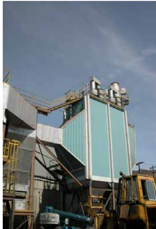
生質能源設施
