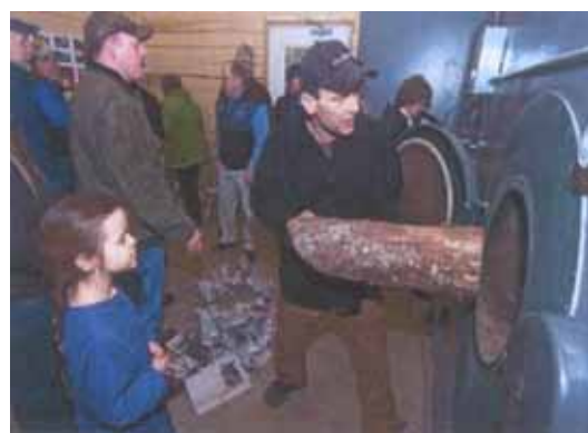
泰德將木料填裝到 GARN 木料鍋爐。鍋爐燃燒供應一個大社區能源並提供團體所需的許多熱水。照片提供:Scott Moon)
