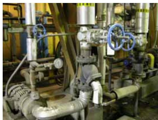
水質處理器－去除河水硫化物
