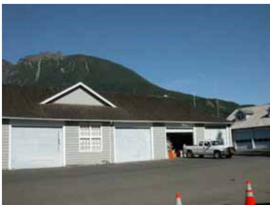
工作站內的防火倉庫
