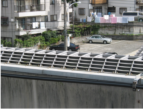
混凝土隔音牆頂設置消音箱Calm Zone
