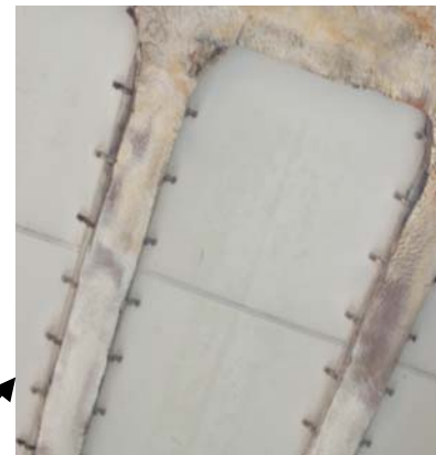
鋼橋下部包覆鋁合金吸音板(內含 10cm 吸音棉)可降低噪音約
