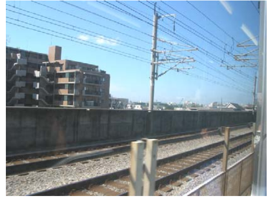
新幹線鐵道2公尺倒L型混凝土隔音牆
