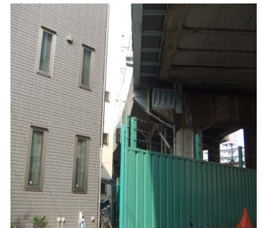
都營地下鐵高架段與民宅相當接近
