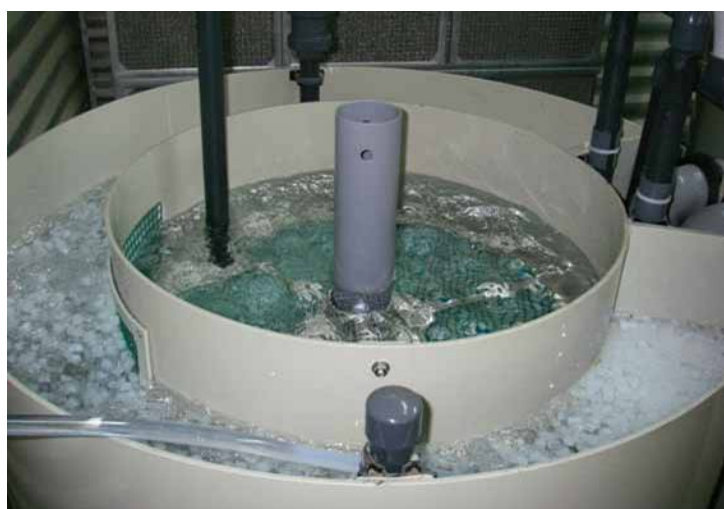
圖 16. 循環飼養系統的過濾桶與濾材。
