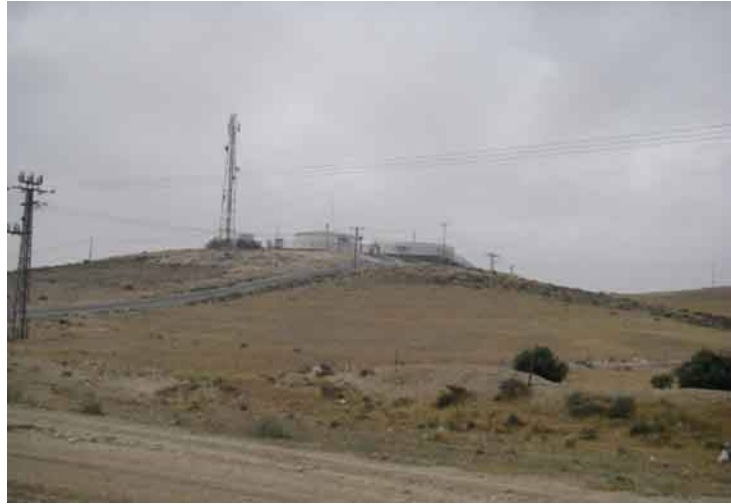
圖 5. 地下半淡鹹水的淡化處理廠。
