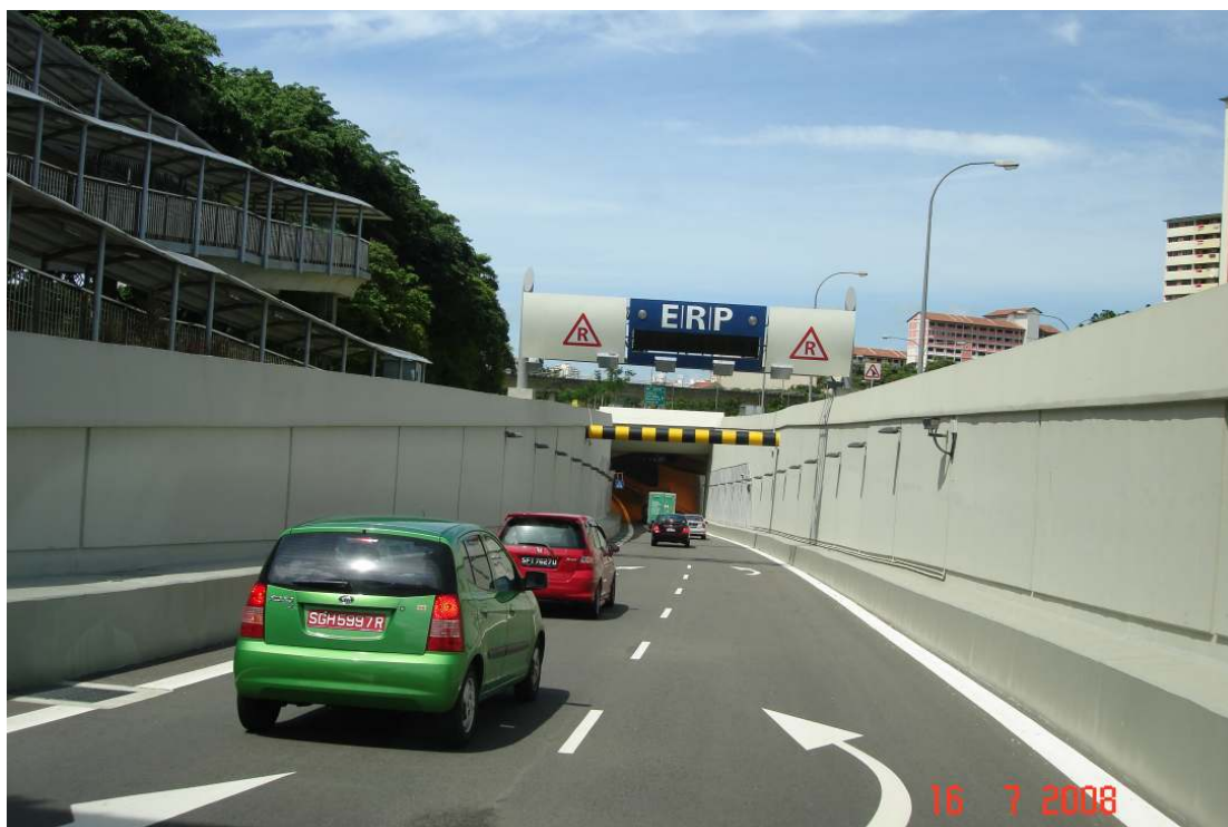
圖 11.KPE 高速公路入口匝道
