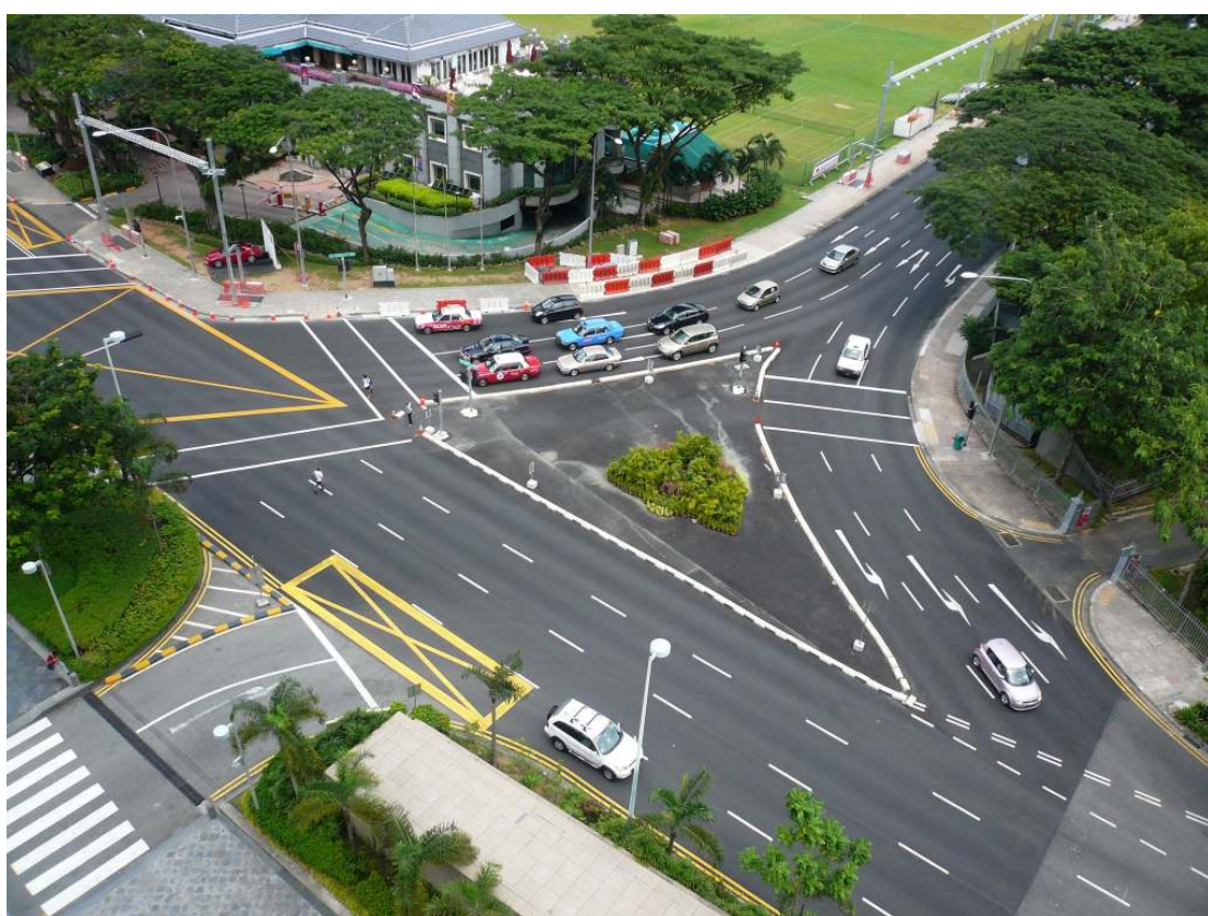
圖 28.為 F1 賽車準備的照明(圖上方門架)和臨時分隔島(圖中央之三角形)
