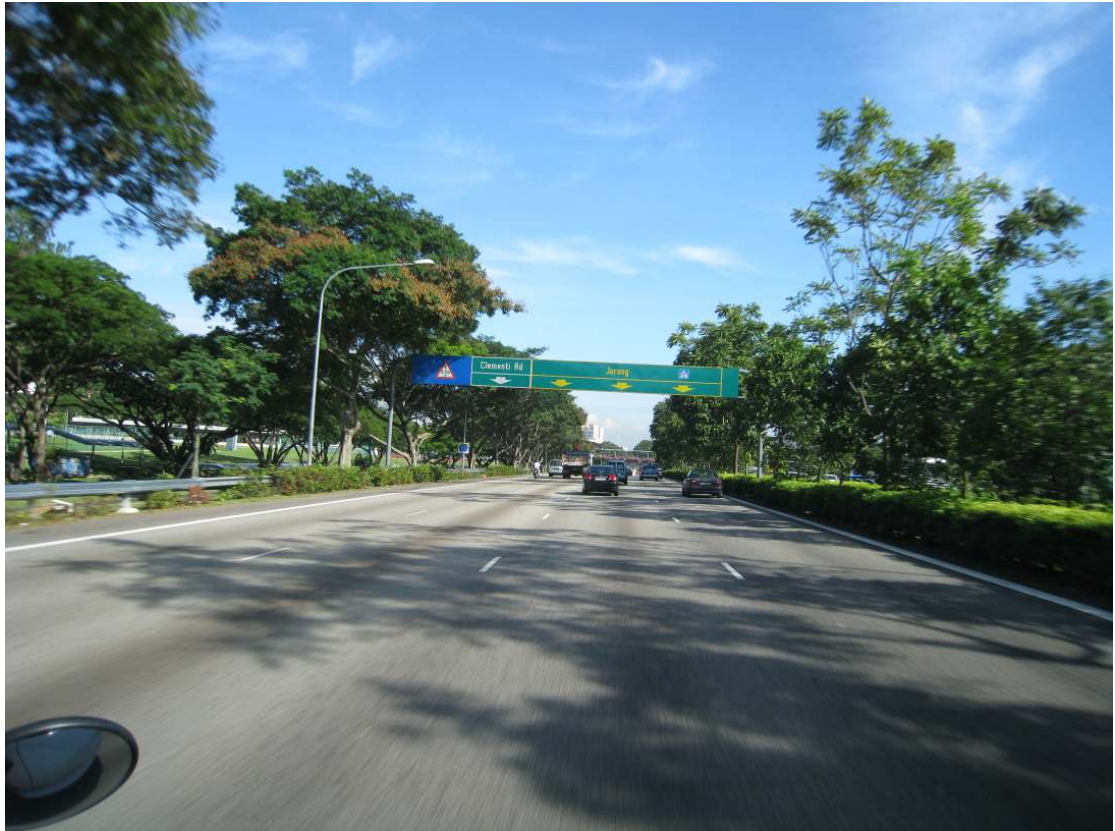
圖 31. 遇出口專用車道時之出口門架處理
