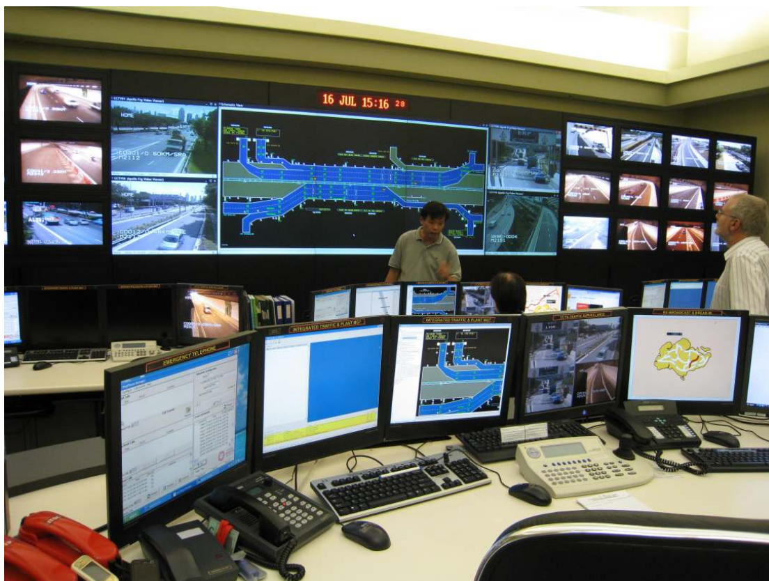
圖 13.KPE 高速公路交控中心控制桌及監視牆
