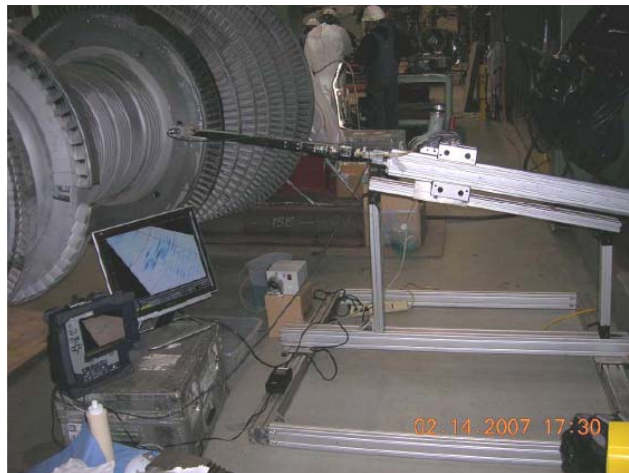
圖 22. PA 檢測 HP-IP 轉子鳩尾槽
