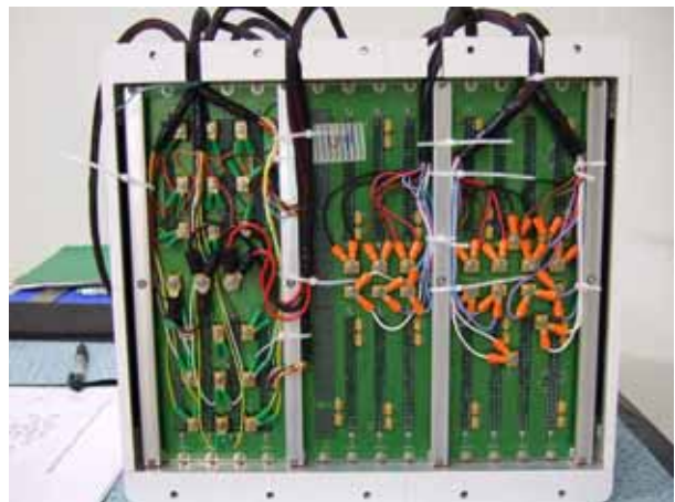
圖六、安裝 U0 最終電源接頭螺絲
