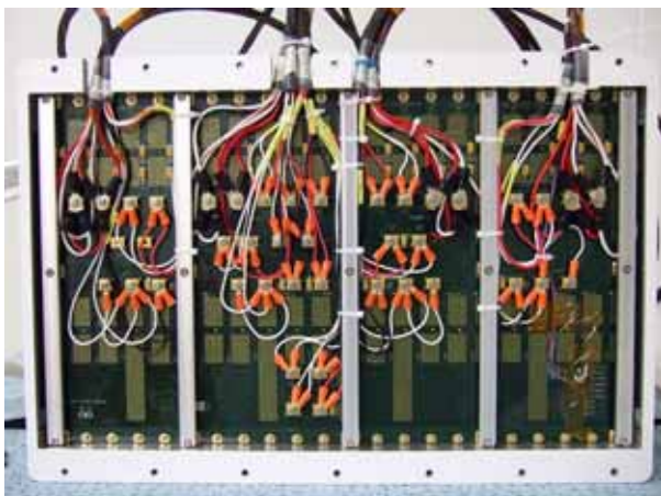
圖九、JT 最終電源接頭螺絲安裝
