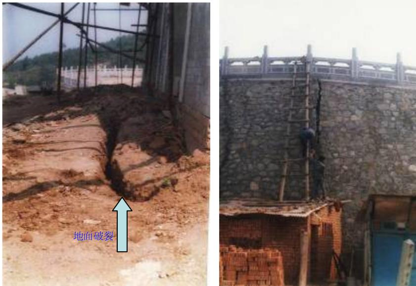
圖四 擋土牆與地面裂縫。
