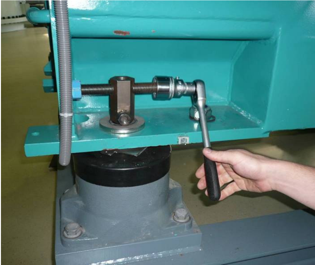
圖 4.16 鬆開發電機三組定位螺栓後置入調整螺栓進行微調
