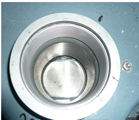
圖 4.10 機艙座(上)與 YAW BEARING(下)之實體圖
