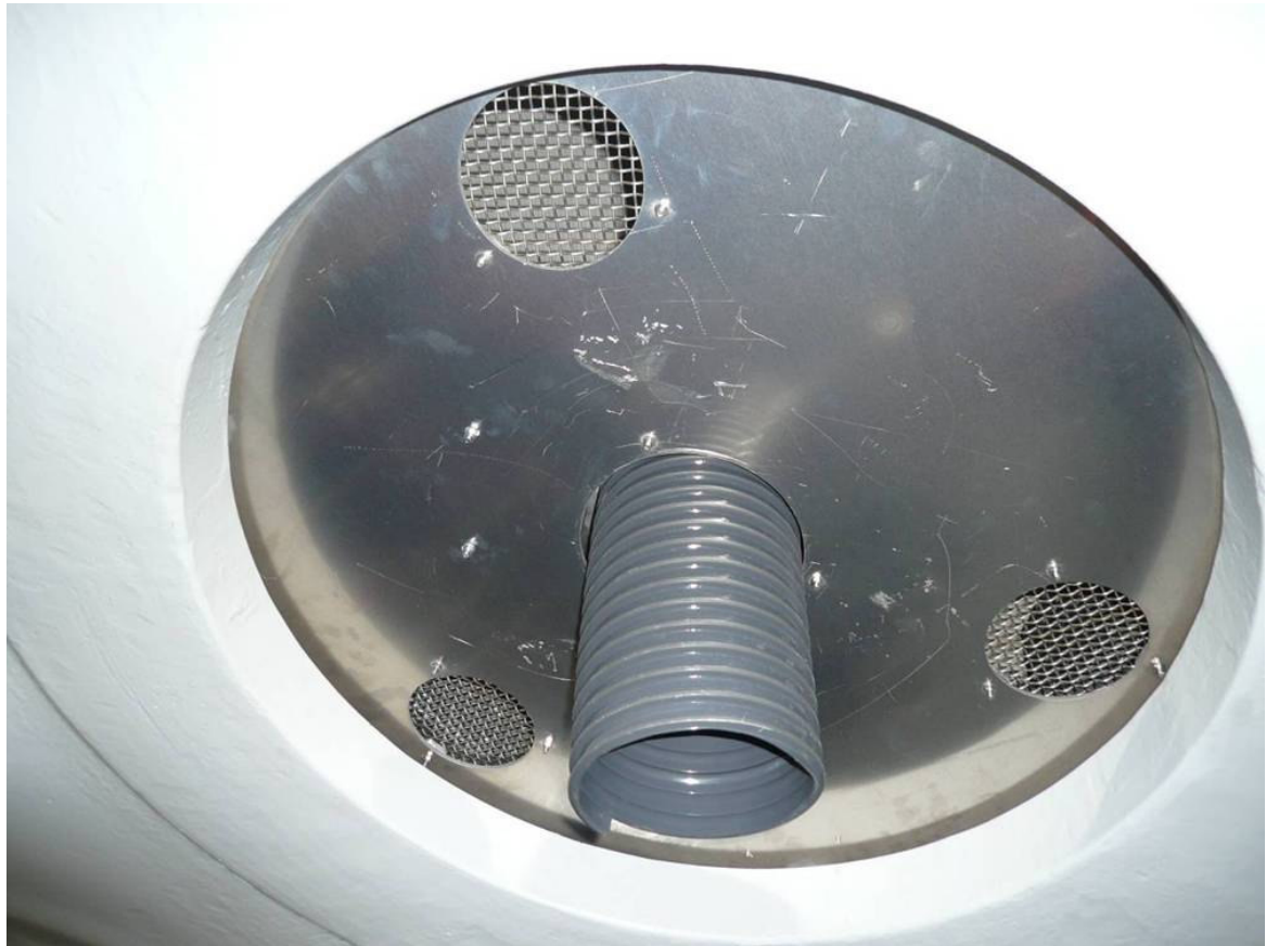
圖 4.34 新型 HUB 入口門板之通風口
