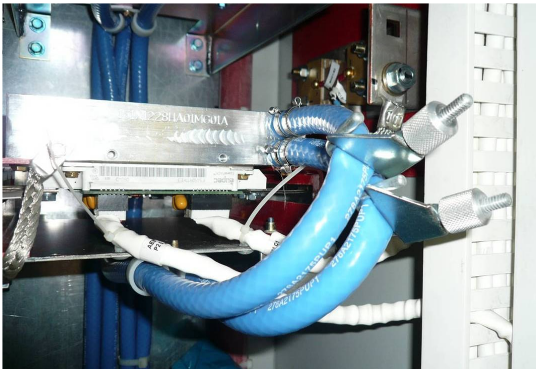
圖 4.29 先以止水夾鎖緊後再切斷冷卻水軟管
