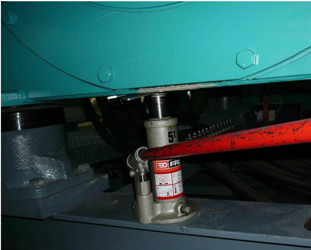
圖 4.17 鬆開發電機兩組定位螺栓以千斤頂頂高後取出或放入墊片
