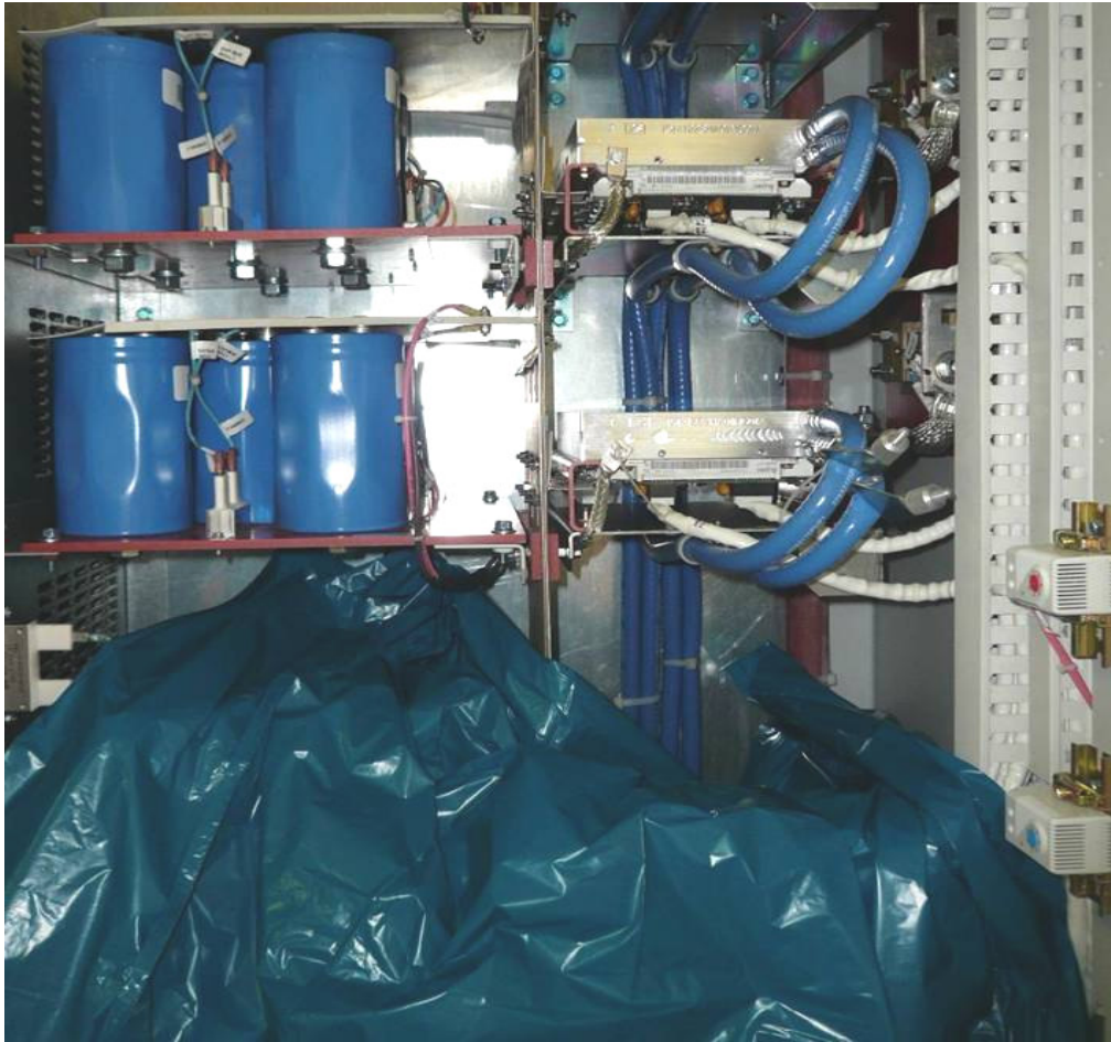
圖 4.28 將防水塑膠布鋪於欲拆下之 IGBT 模組下方
