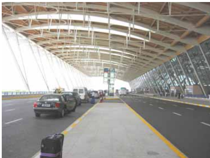
圖 3.4.2-4 浦東機場路緣停車情形
