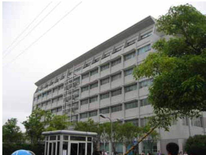
圖 3.4.2-2 上海浦東國際機場貨運站有限公司
