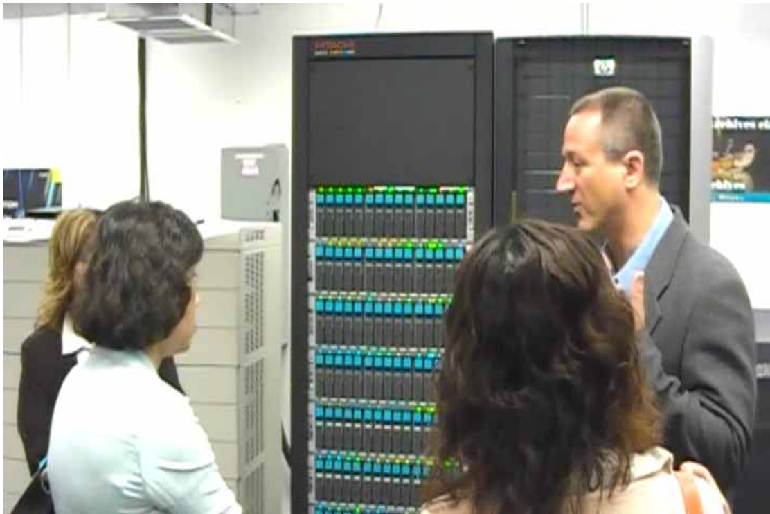
保存維護中心數位檔案儲存機組之 1
