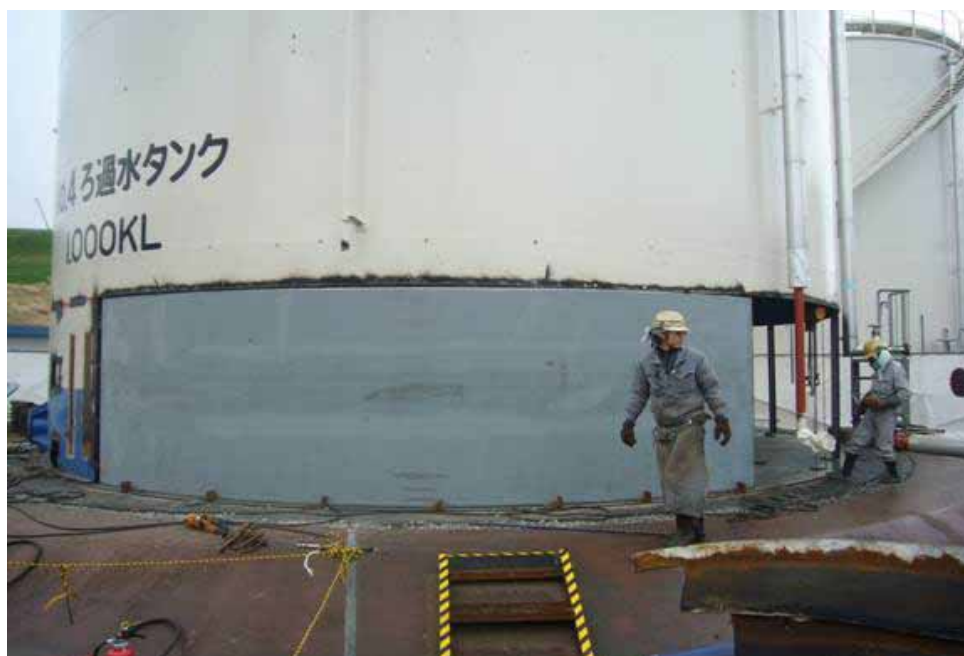
照片 6 過濾水槽下圍切除修補
