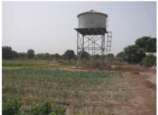
圖 10. 水塔高度足夠滴灌壓力
