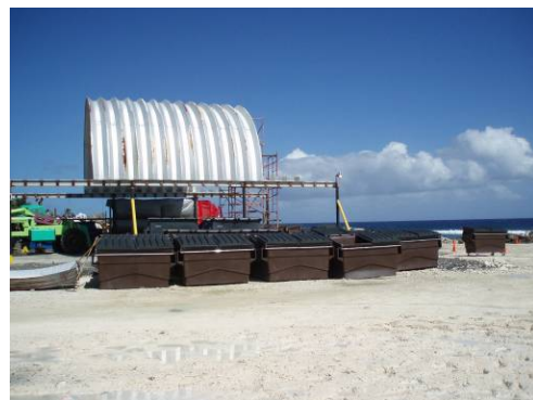
圖 22 掩埋場現場留置一些小型垃圾收集子車情形
