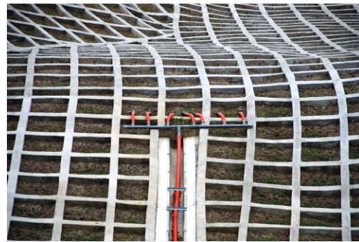
圖 2.3.6-17 格框及橫向鑽孔排水
