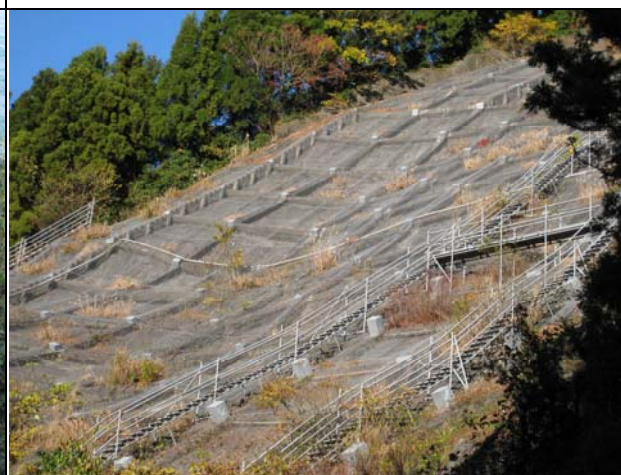
圖 2.3.3-9 深層滑動以地錨施工
