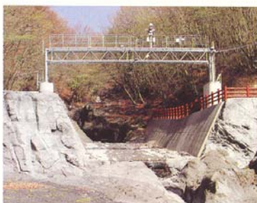
岩樋下流地点の土石流観測橋
