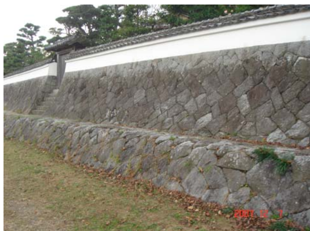
圖 2.3.7-2 以砌石方式興建擋土牆
