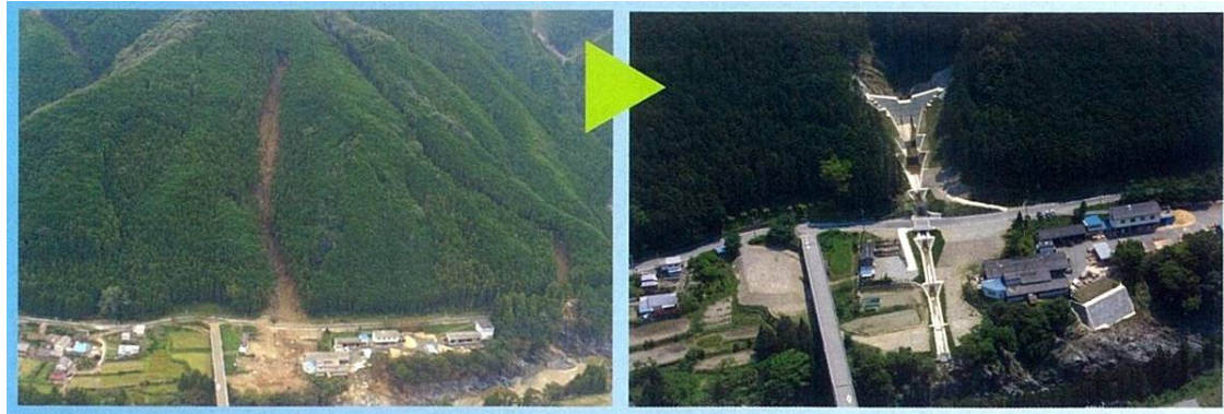
圖 2.3.6-18 唐櫃 1 土石流災害及復建情形（2006.11 完成）
