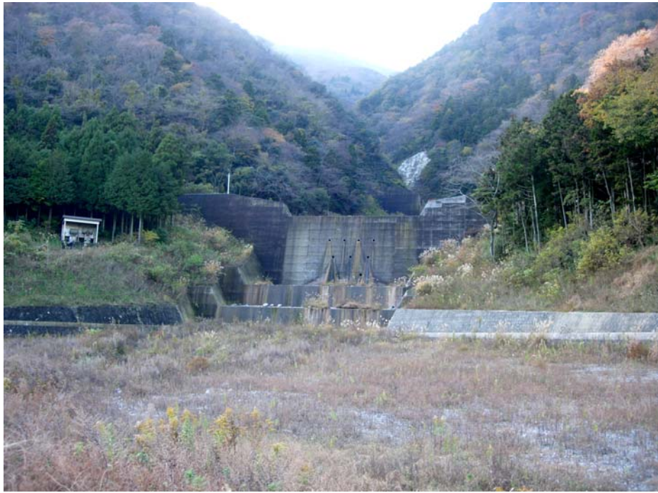
圖 2.2.2-10 三重縣藤原岳週邊小滝川土石流整治(下游村落旁)
