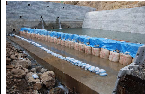
圖 2.3.6-10 現場擋排水工程
