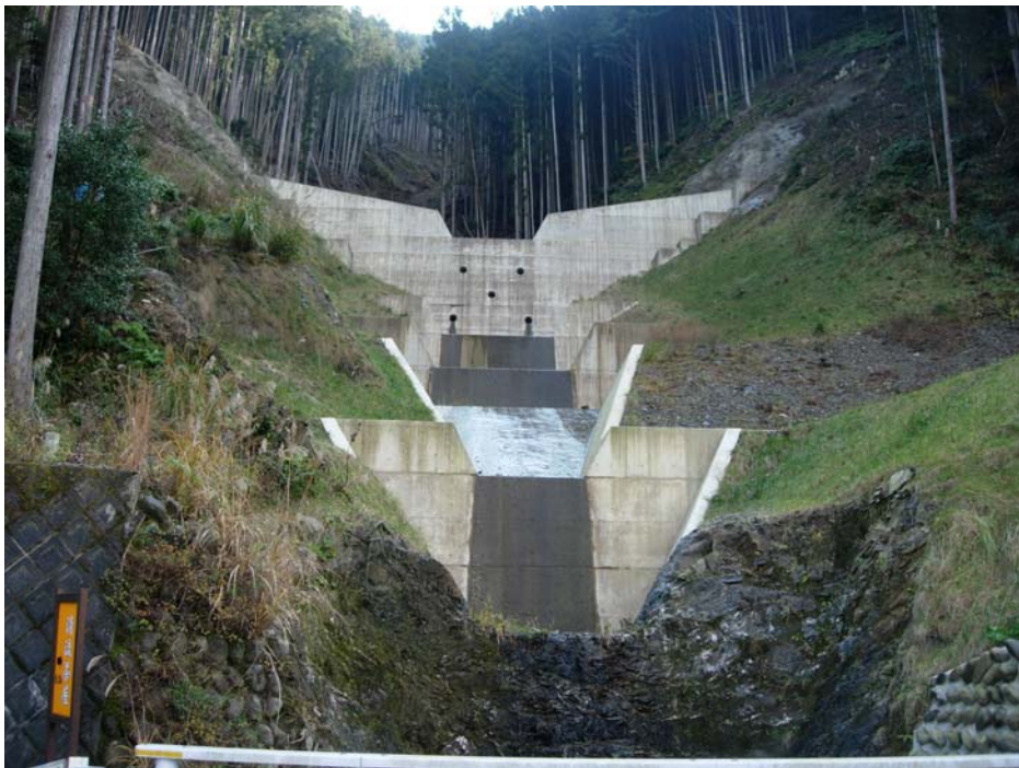
圖 2.2.2-11 三重縣大台町唐櫃 1 道路上邊坡
