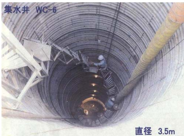
圖 2.3.3-5 集水井施工情形
