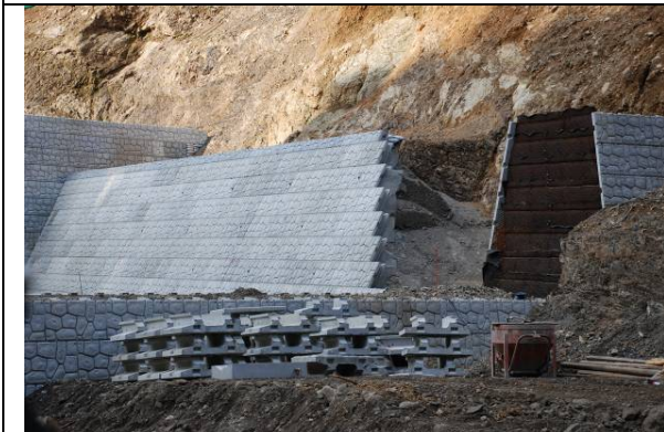
圖 2.3.6-8 INSEM-雙牆法施工剖面
