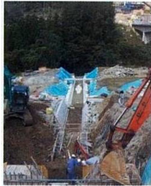
圖 2.3.6-20 唐櫃 1 野溪復建施工情形
