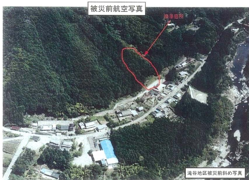
圖 2.3.6-12 滝谷地區災害前照片
