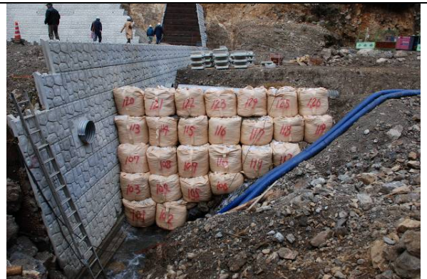
圖 2.3.6-11 現場擋排水工程
