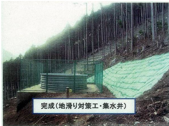
圖 2.3.6-28 小滝地區地滑復建情形
