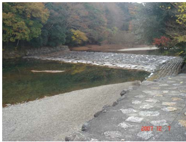
圖 2.3.7-2 塊石興建固床工具高壩低矮矮化功能
