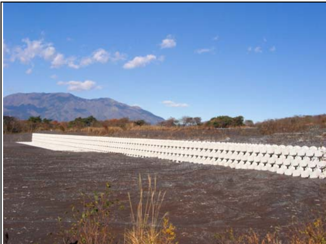
圖 2.3.2-3 大澤川扇狀地第 8 床固工
