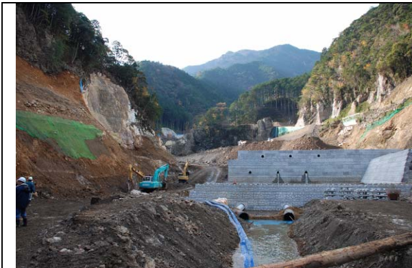
圖 2.3.6-6 春日谷川 1 號壩施工現場
