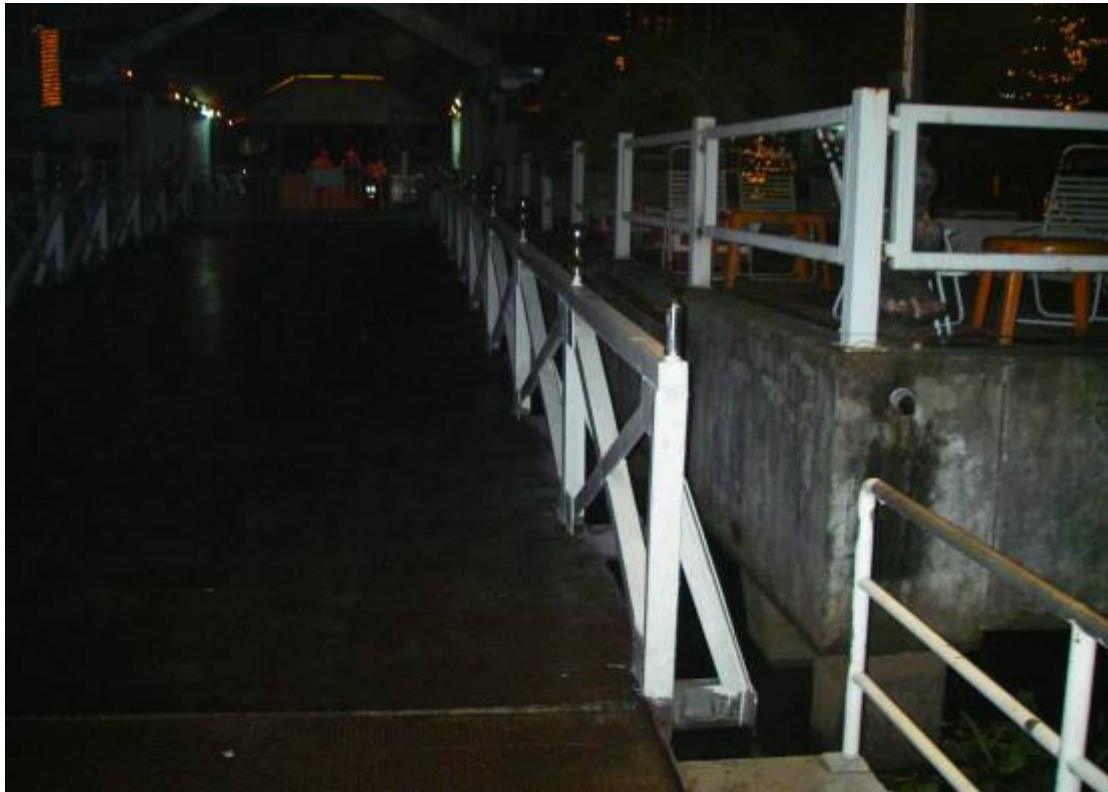
遊艇靠泊之浮動舷橋
