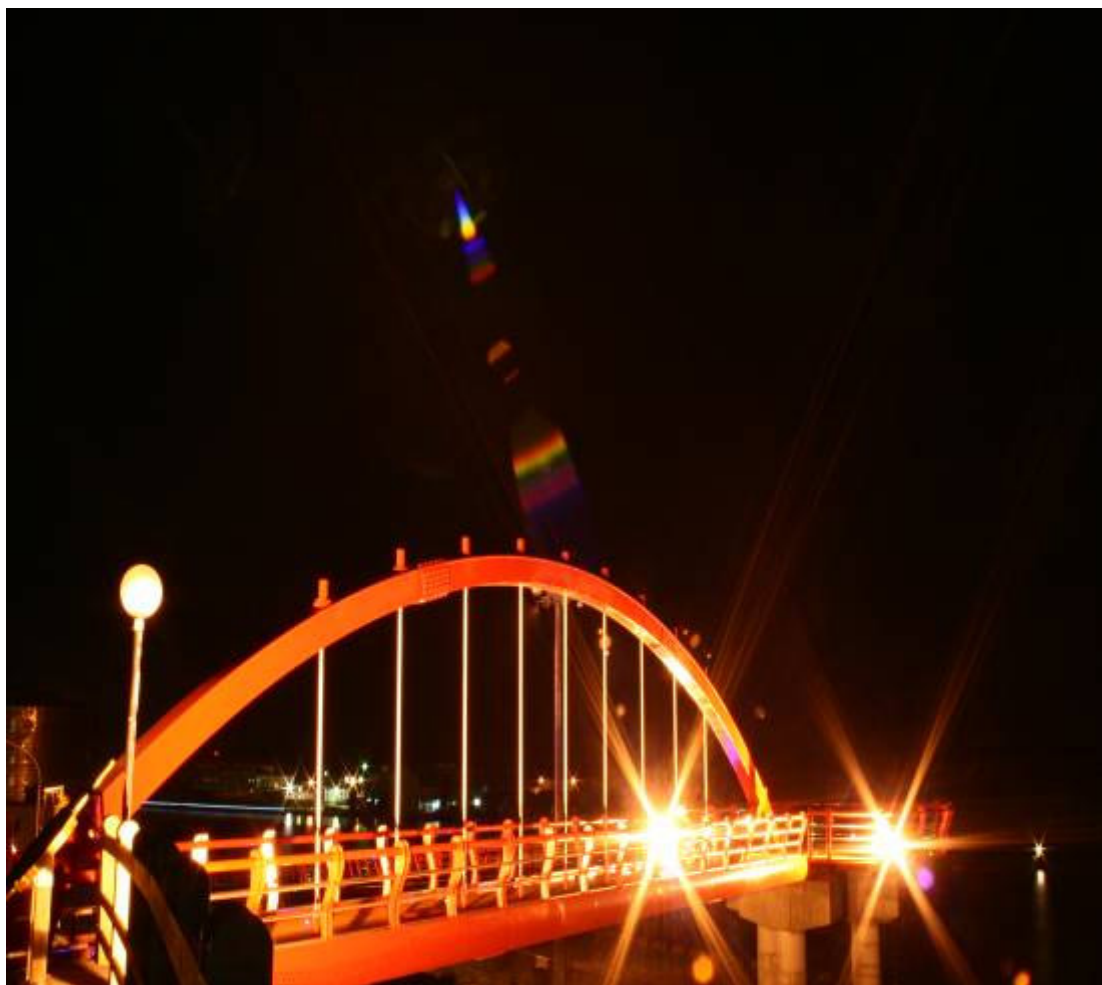
已建置完成花蓮港景觀橋夜景圖
